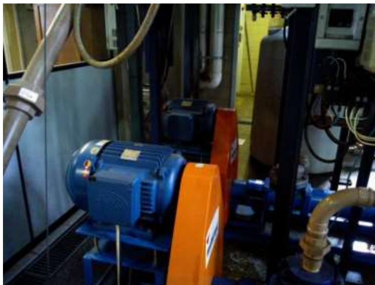
Figura 10. Bombas helicoidales de suministro de agua y aceite.
