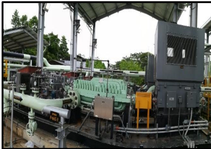
Figura 4. Bomba de inyección multietapa de carcasa partida
