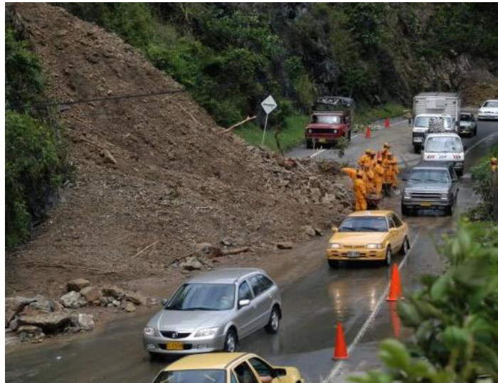
Figura 2. Deslizamiento de tierra, a causa del invierno en la vía Medellín – Santa Fe, en el sector de las Meloneras
