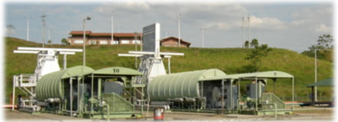
Figura 2. Generador de vapor
