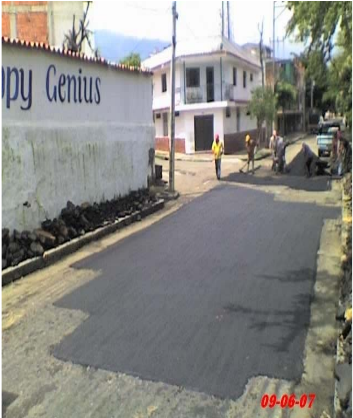
Figura 28. Tramo de prueba compactado
