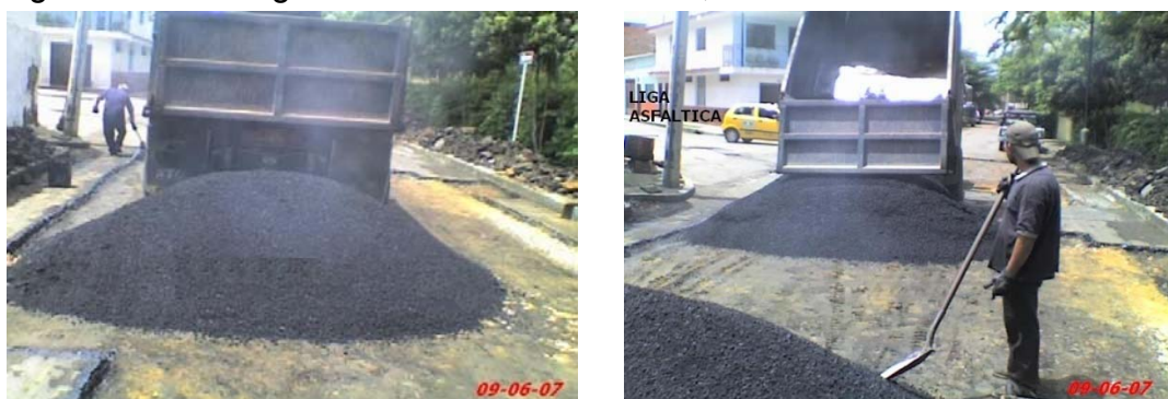
Figura 24. Descarga de mezcla asfáltica con 1,5% de Cal Hidratada
