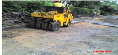
Figura 11. Compactación de la Base
