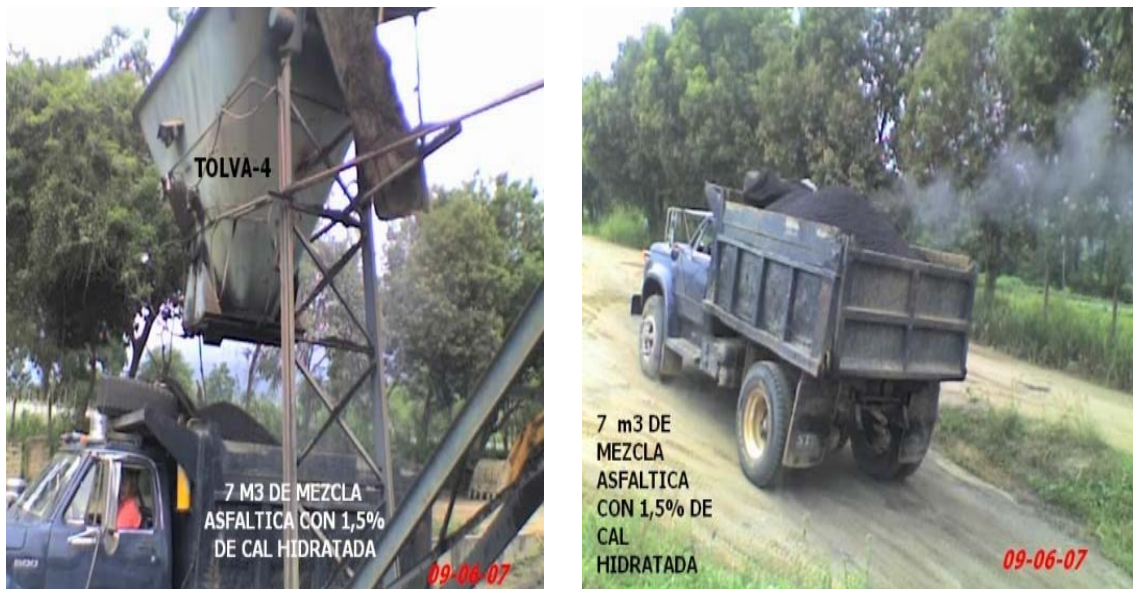
Figura 22. Cargue y transporte de mezcla asfáltica
