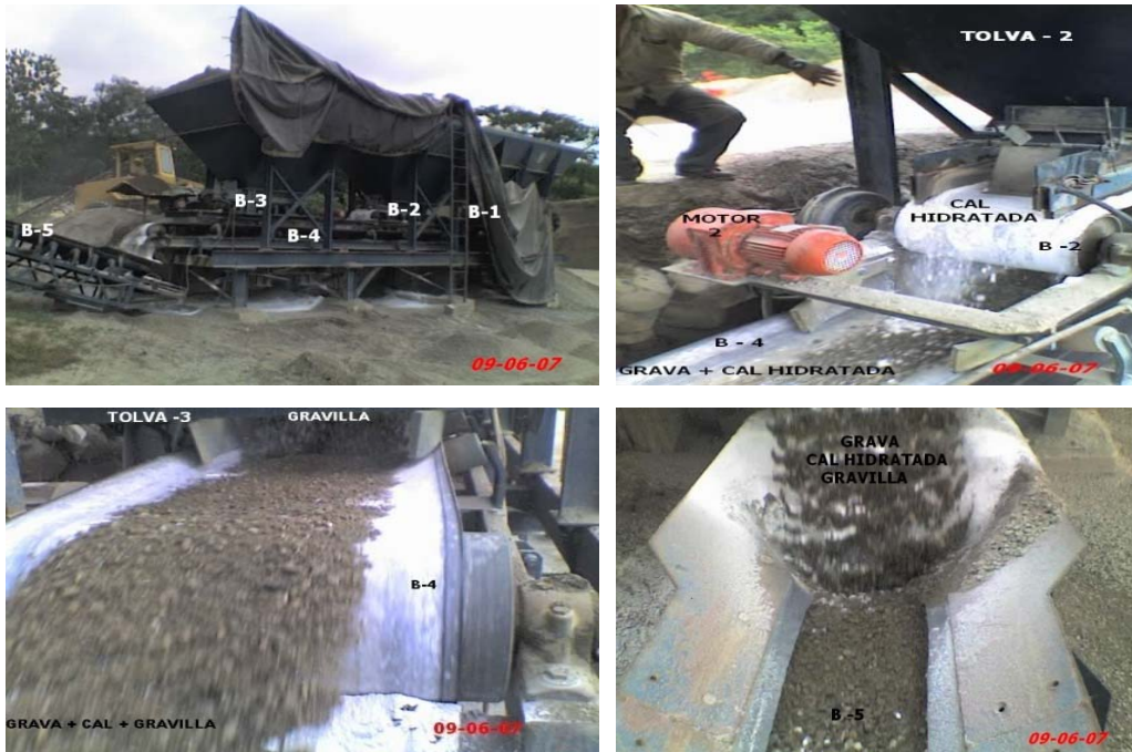
Planta de mezclas asfáltica de TECNOPAVIMENTOS
