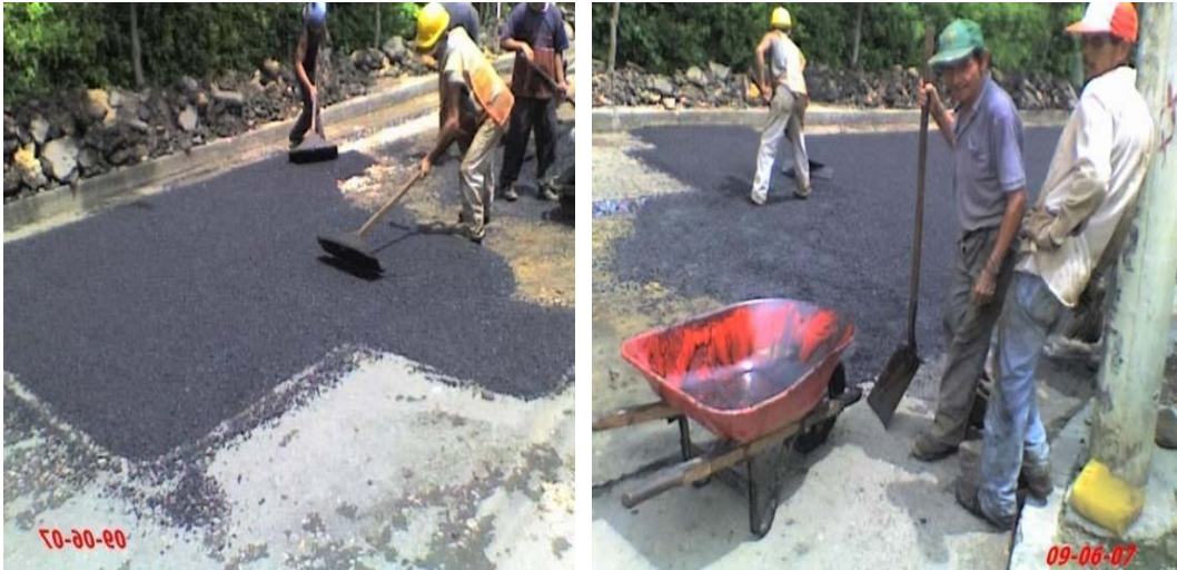
Figura 25. Nivelación de mezcla asfáltica con 1,5% de Cal Hidratada
