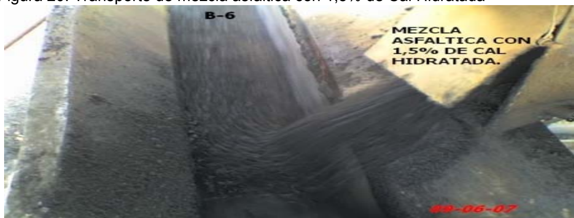
Figura 20. Transporte de mezcla asfáltica con 1,5% de Cal Hidratada
