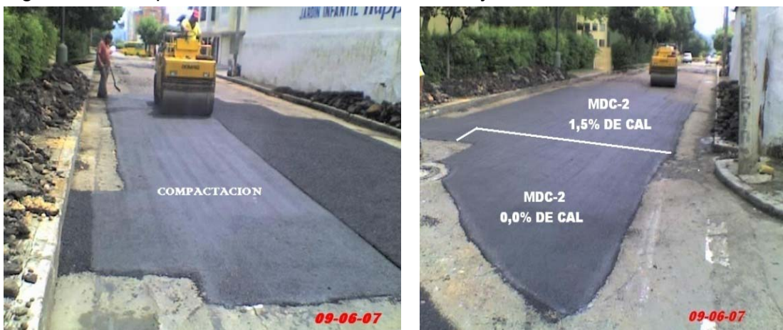
Figura 27. Compactación de mezclas con 0,0% y 1,5% de Cal Hidratada
