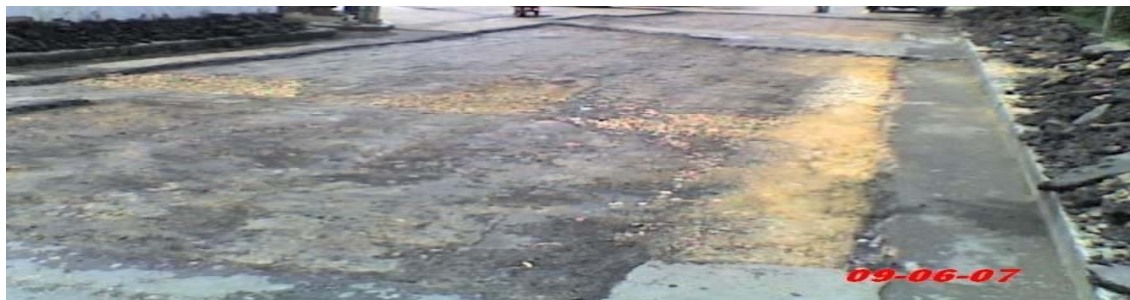
Figura 10. Caja para aplicación de mezcla asfáltica con 0,0% y 1,5% de Cal
