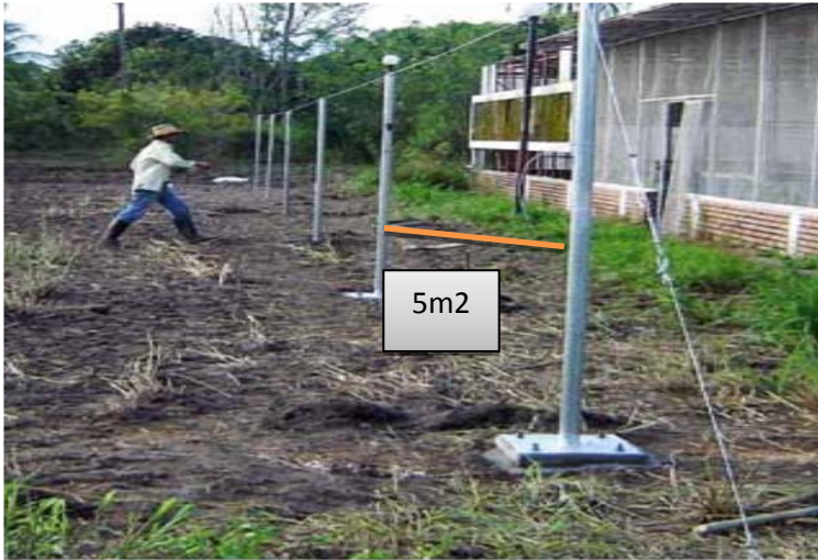
Ilustración 16 montaje estructura mecánica
