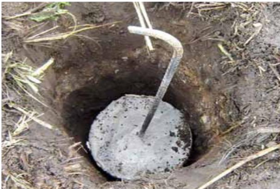
Ilustración 18 colocación de pie de amigo para templete
