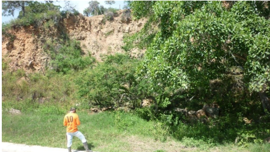
Imagen 55. Área con erosión extrema ubicada en la Parte Media, Microcuenca Popagá. Coordenadas 1150125.76 Este y 1227563.79 Norte
