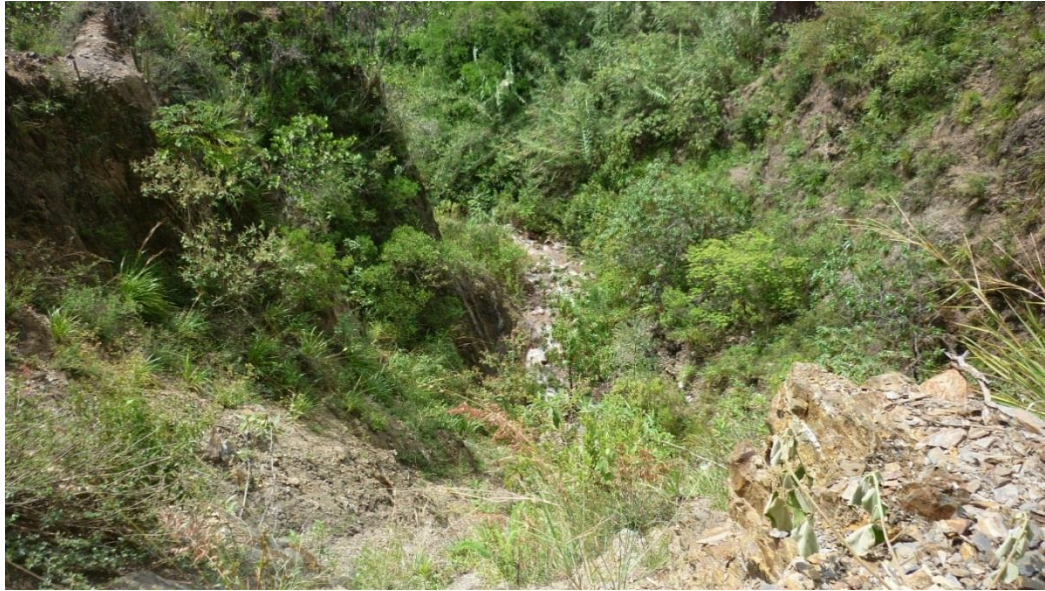
Imagen 58. Área con erosión extrema ubicada en la Parte Media, Microcuenca Tabarlaque. Coordenadas 1147854.31 Este y 1223156.96 Norte
