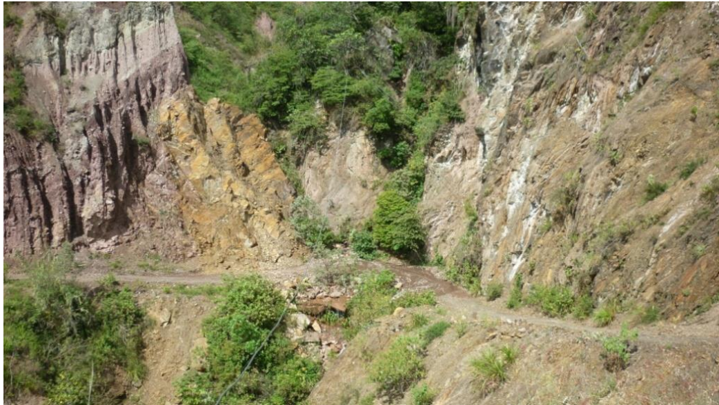
Imagen 56. Área con erosión extrema ubicada en la Parte Media, Microcuenca Tabarlaque. Coordenadas 1146956.84 Este y 1223332.64 Norte
