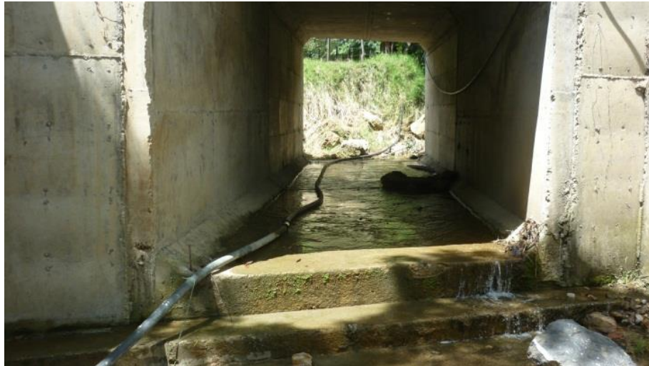
Imagen 13. Canal abierto km 32+ 293 m vía San José de Miranda- Málaga
