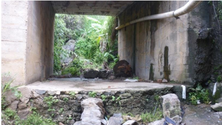
Imagen 3. Tramo canalizado vía San José de Miranda- Málaga Km 33+860 m
