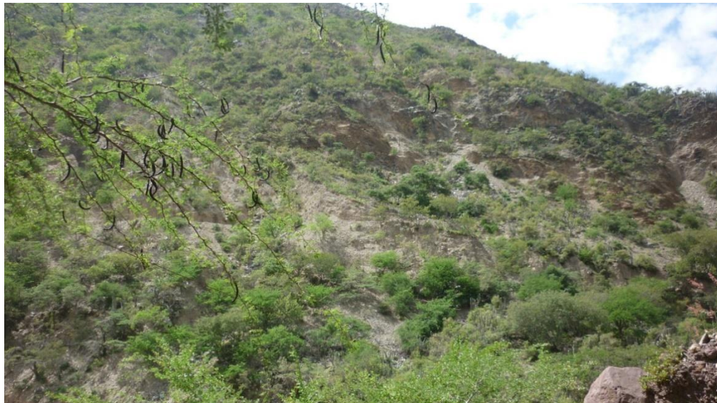
Imagen 61. Área con erosión extrema ubicada en la Parte Baja, Microcuenca Tabarlaque. Coordenadas 1146274.64 Este y 1220000.06 Norte
