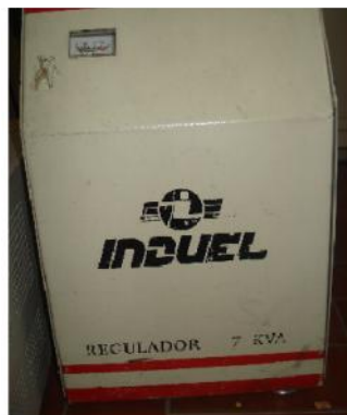
Figura 24. Fotografía del Regulador 7kVA.
