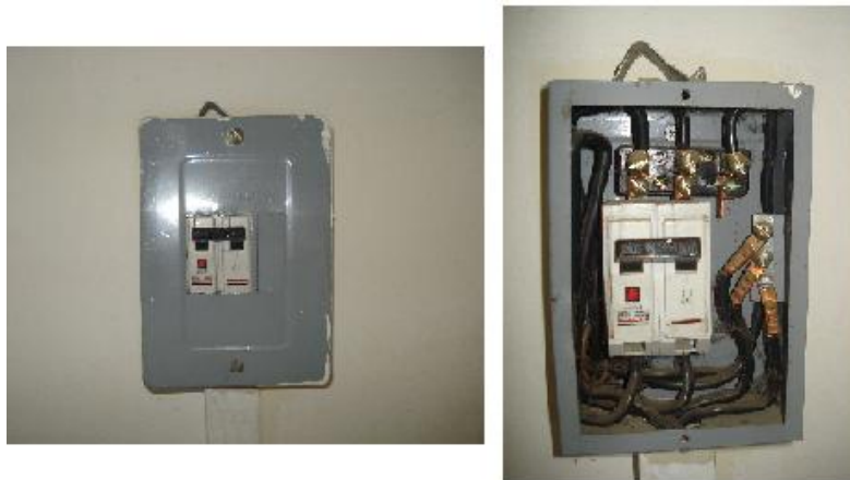
Figura 26. Fotografía del Tablero TJ.
