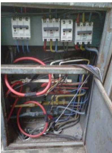
Figura 53. Fotografía del Montaje del Analizador de Redes.
