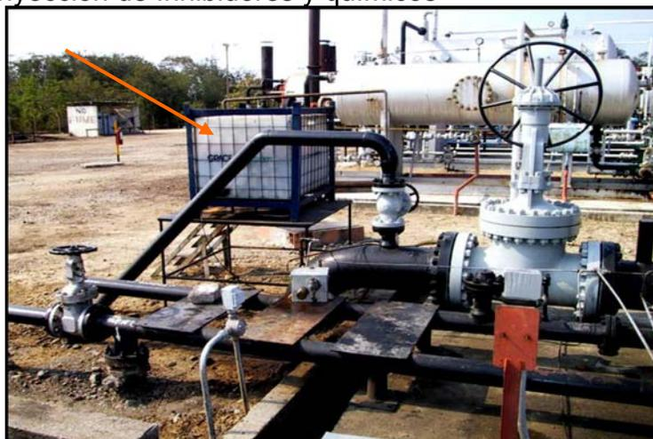
**2.1.14 Depurador de gas.** El gas proveniente del separador de prueba, del separador de agua libre (FWKO) y de los tratadores electrostáticos fluye a una pareja de enfriadores con agua y pasa al tambor vertical depurador, donde el crudo arrastrado por el gas se separa. Este gas es utilizado para el encendido de los quemadores existentes en el módulo, el líquido decantado va al separador API.
