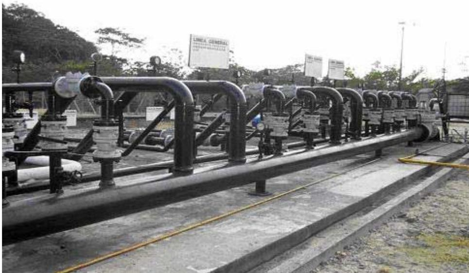
**2.1.3 Tuberías o líneas internas.** Conducen los fluidos desde el múltiple hasta las vasijas de tratamiento; intercomunican vasijas; sirven de succión y descarga de bombas y compresores; o drenajes y venteos.
