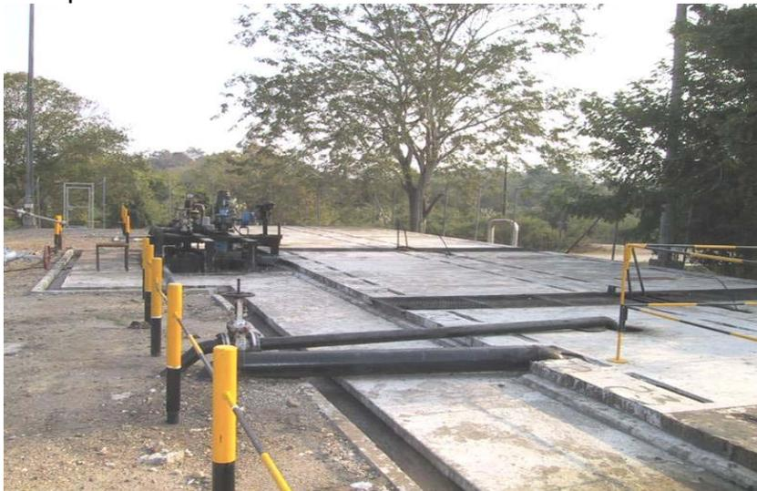
Esta provisto de bombas y motores eléctricos para recuperar el aceite y enviarlo nuevamente al tratamiento, igualmente se direcciona el agua al sistema de tratamiento residual
