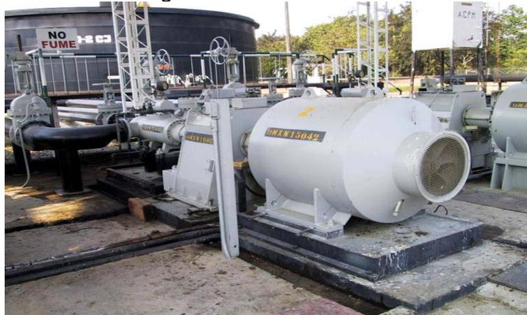
**2.1.13 Sistemas de Inyección de inhibidores y químicos.** Compuestas regularmente de recipiente de almacenamiento y mezcla, bombas de dosificación o proporcionadoras, inyectores de químicos en puntos de inyección, tuberías y accesorios.
