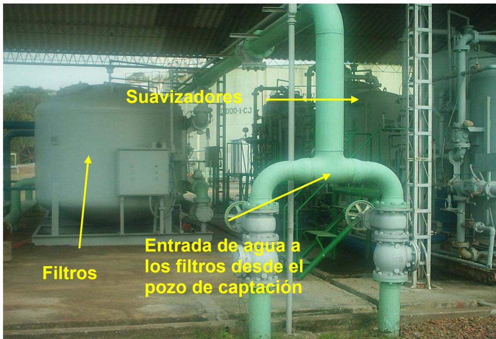
La filtración del agua es el proceso mediante el cual las materias en suspensión son separadas del agua haciéndolas pasar a través de un medio poroso. En la práctica este medio poroso es generalmente arena.
