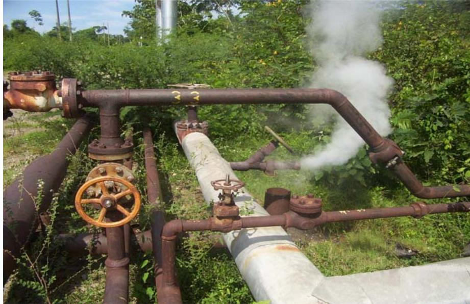
**8.2.4 Mal estado del material aislante.** Alrededor del campo, se encuentran tramos de tubería de vapor en los cuales se nota una falta total o parcial del material aislante (lana de fibra de vidrio), esto debido a que la lamina de aluminio que lo recubre y protege es frecuentemente blanco de robos por parte de habitantes de la zona para ser vendido como material reciclable.
