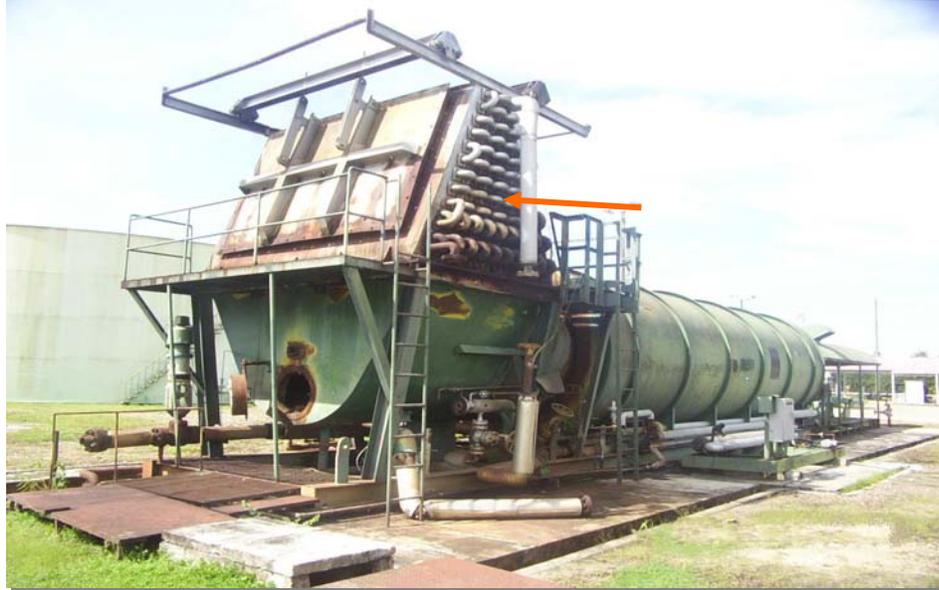
➤ **Zona radiante y quemador.** Es la sección donde se recibe el calor final para convertir el agua en vapor al 80 %, es de forma cilíndrica y está provisto de una serie de tubos ordenados en forma horizontal, de igual manera consta de un material refractario que protege la coraza metálica minimizando las pérdidas de calor.
