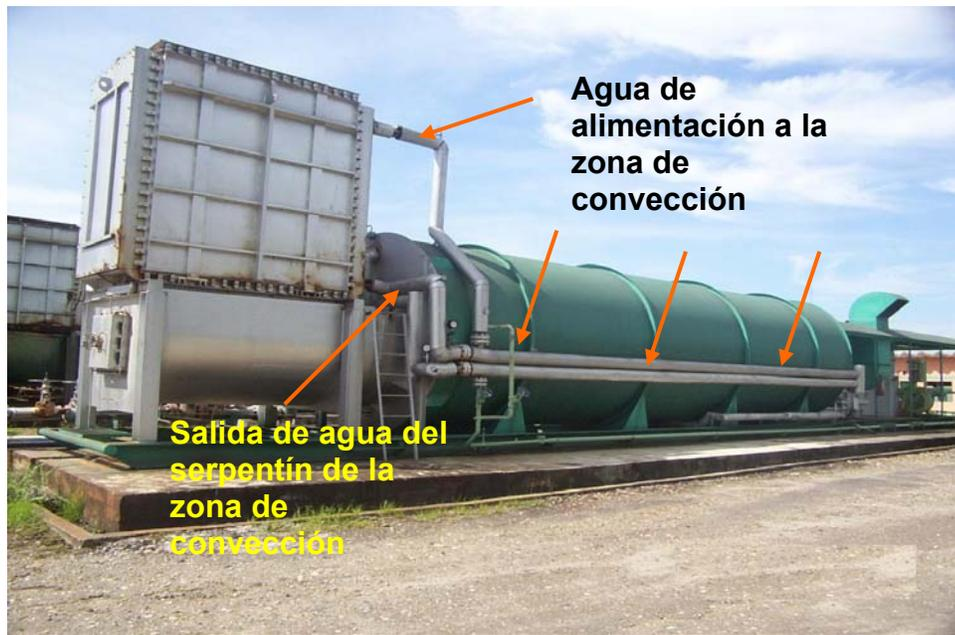
➤ **Serpentín de la zona de convección.** Los tubos han sido diseñados para absorber el calor proveniente de los gases de combustión elevando la temperatura desde 280 °F a 500 °F. Estos tubos se encuentran provistos de aletas para aumentar la superficie de transferencia de calor.
