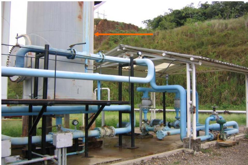
**3.5.4 Tanque de almacenamiento.** Obteniendo el agua filtrada con el filtro de cáscara de nuez, se almacena en un tanque con capacidad para 5000 barriles donde finalmente va a ser tomada por las bombas triplex de desplazamiento positivo para ser inyectada en los pozos inyectores.
