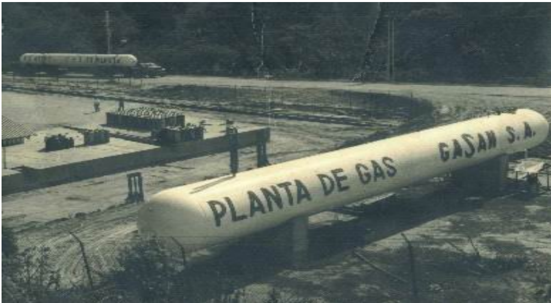
Figura 2. Construcción planta principal GASAN.
