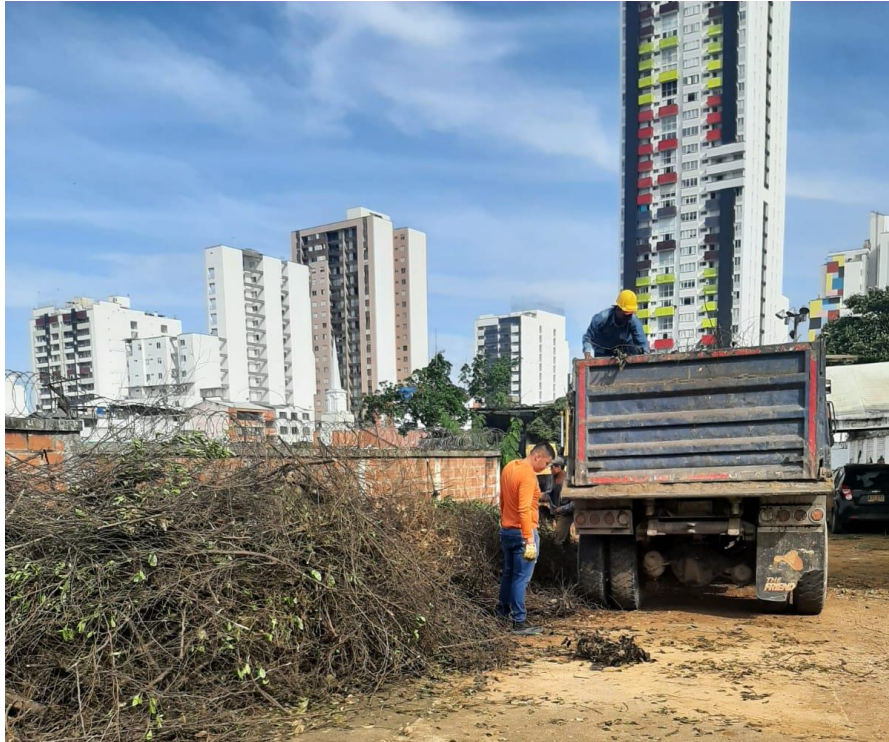
Figura 11. Cargue de volquetas con Material vegetal
