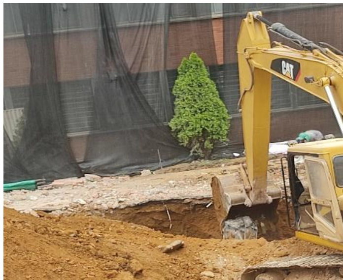
Figura 2. Retiro de cimentaciones
