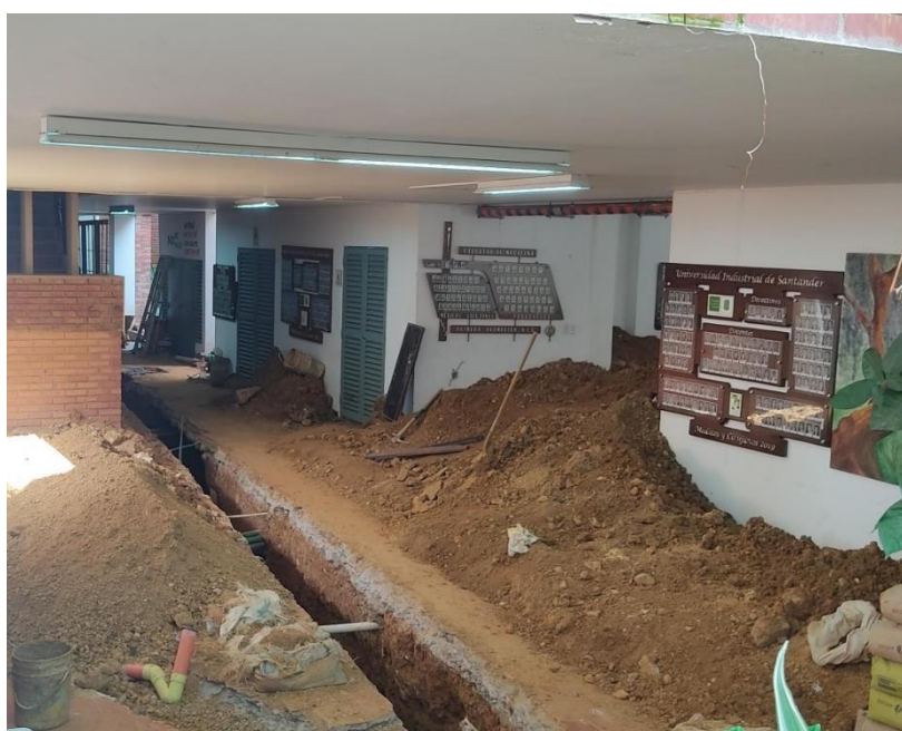
Figura 8. Excavación y nivelación de la zanja.
