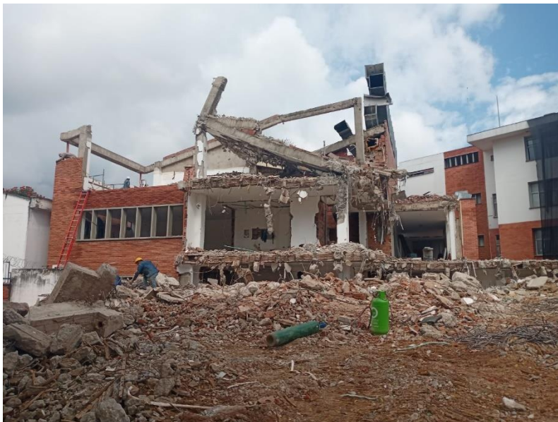
Figura 1. Demolición Biblioteca Orlando Díaz Gómez.
