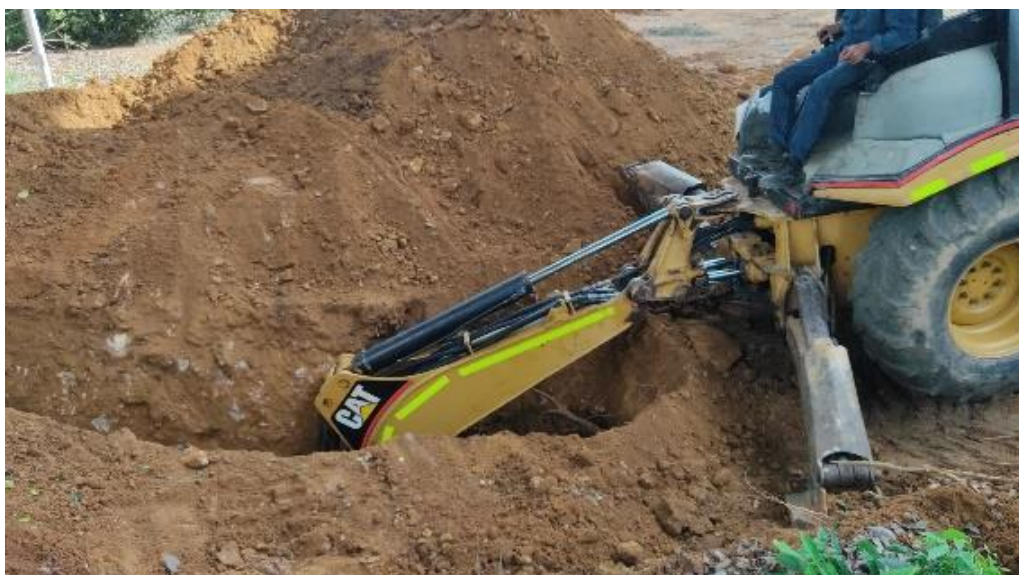
Figura 4. Excavación de zanja para la localización de la tubería
