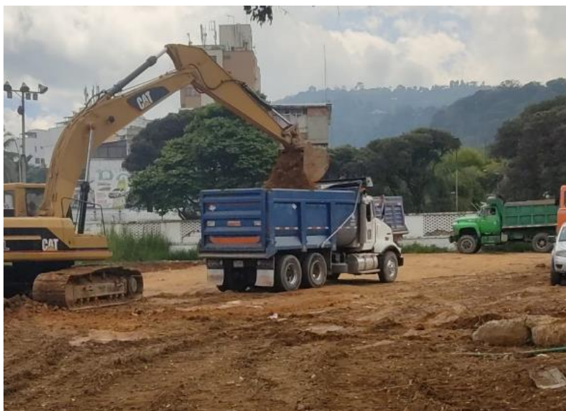
Figura 10. Cargue de volquetas con Tierra
