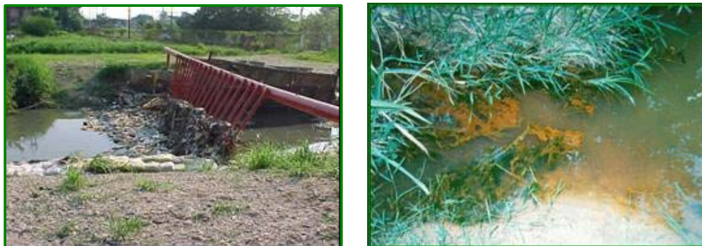
Figura 11. Recurso agua afectado por residuos sólidos y lixiviados.
