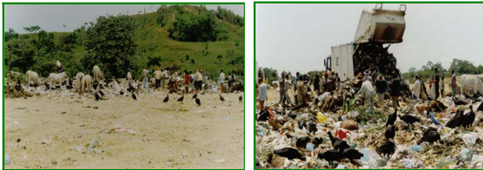
Figura 17. Relleno sanitario en clausura.
