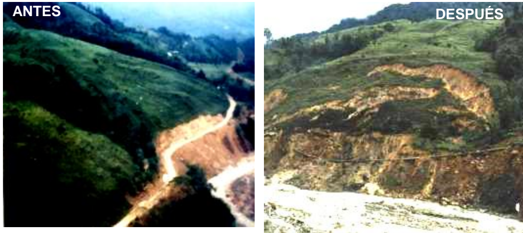
Foto 12. Movimientos súbitos ocasionados por el detonante lluvias.
