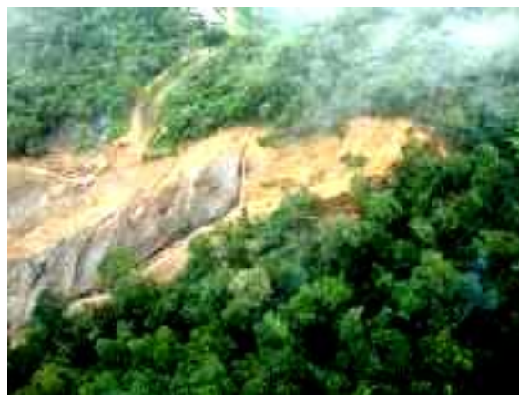
Foto 7. Rotura del ducto por deslizamiento súbito, causando incendio afectando el entorno.
