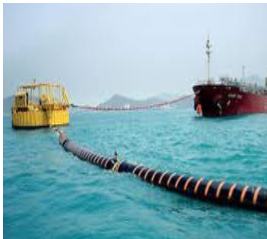
Foto 4. Triángulo Coveñas TLU1 - TLU3 de la VIT, ECOPETROL S.A.
