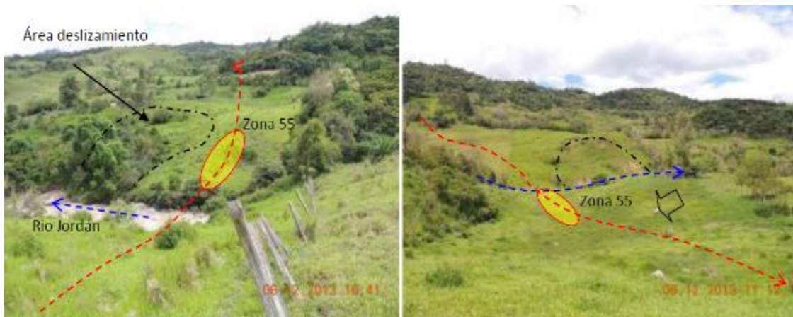
Foto 16. Localización de zonas Bending Strain en la vecindad de cruce de cuerpos de agua
