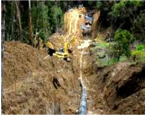
Foto 15. Actividades de reparación de la tubería en sitio de inestabilidad geotécnica
