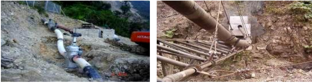
Fuente: Departamento O&M Oleoductos Caño Limón Coveñas
