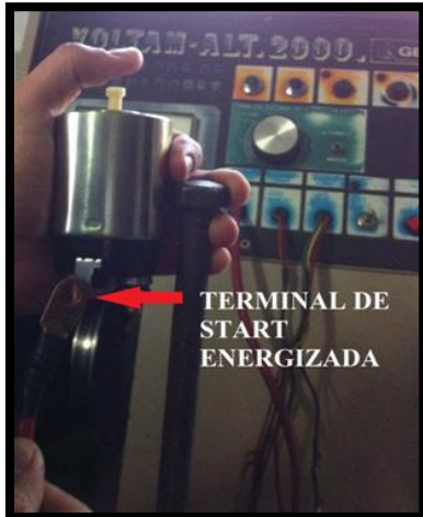
Imagen. Terminal "start" Energizada. Fuente. Propia.
