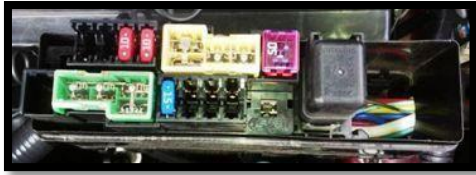
Imagen. Fusibles Principales. Fuente. Propia.
