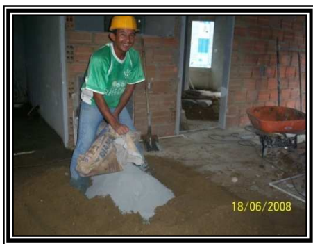
Fotografía 8. Actividades desarrolladas durante el proceso de “Frisado de muros”.
