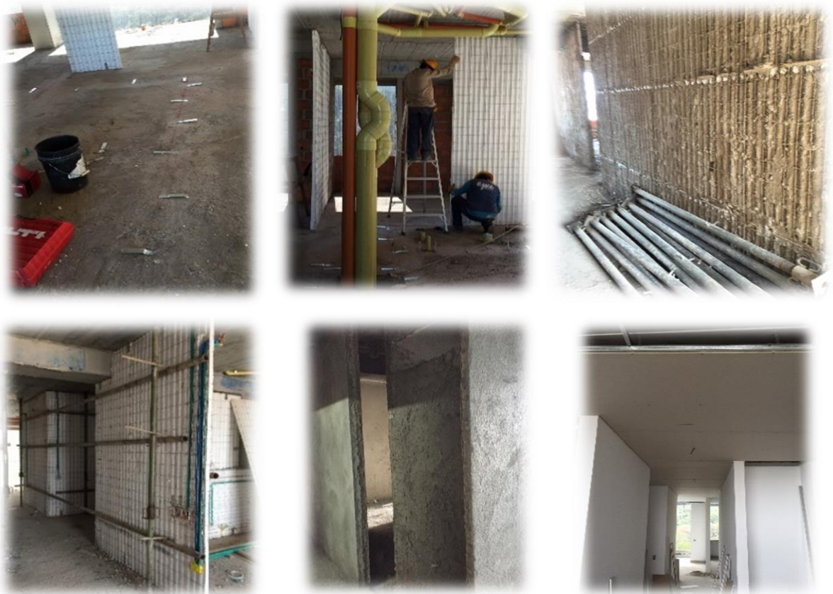
Figura 20. Proceso de instalación de muros durapanel con acabados finales.
