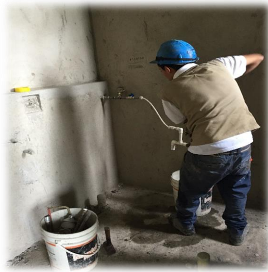
Figura 4. Herramientas empleadas para la prueba de presión en redes hidráulicas.
