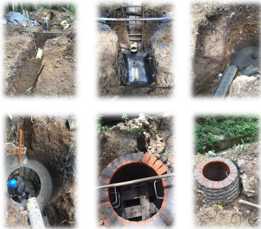
Figura 16. Instalación de tubería para descole del alcantarillado aguas lluvias y construcción de pozos.
