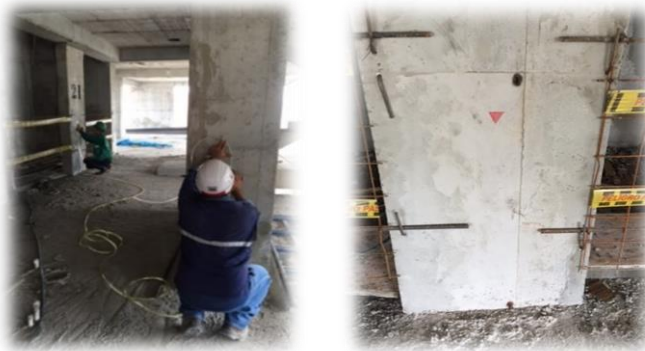
Figura 17. Proceso de traslado y marcada de niveles.
