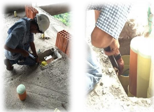
Figura 8. Ejecución de la prueba de estanqueidad en redes sanitarias.
