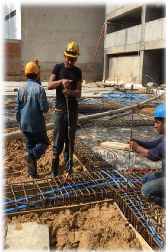
Figura 18. Procedimiento de traslado de niveles en la cancha de tenis.
