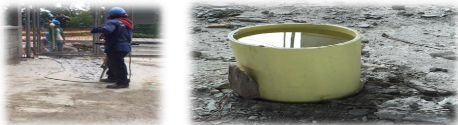
Figura 9. Nivel inicial de un punto sanitario en la prueba de estanqueidad.
