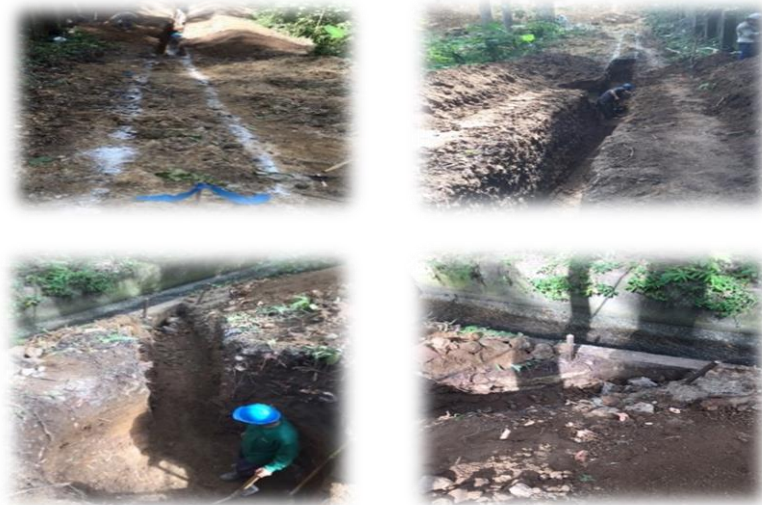
Figura 15. Excavación del primer tramo de tubería y del pozo 11.
