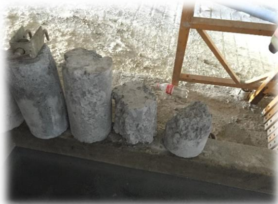
Figura 26. Muestras del concreto utilizado en las 4 columnas.
