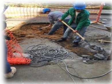
Figura 10. Rotura de la vía para dar inicio del alcantarillado aguas negras.
