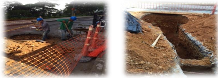
Figura 11. Excavación inicial para la construcción de los pozos del alcantarillado aguas negras.
