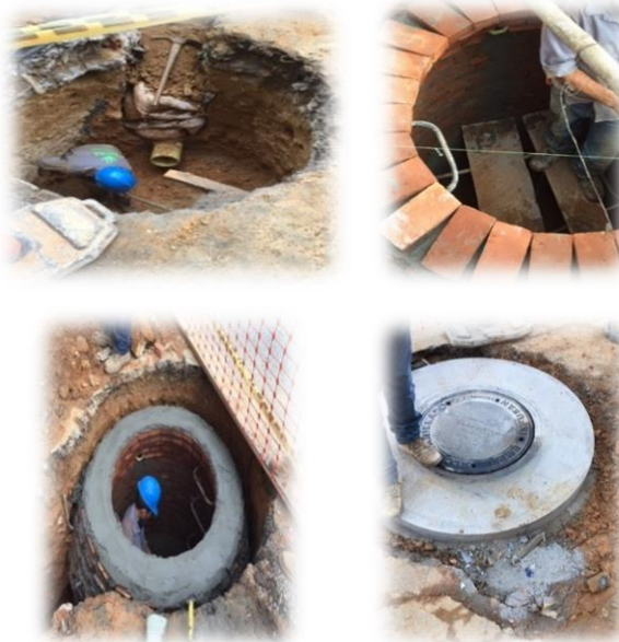
Figura 13. Proceso construcción de los pozos para el alcantarillado aguas negras.
