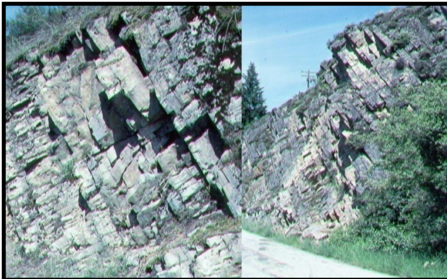
Fotografía 13. Rotura por Volcamiento
