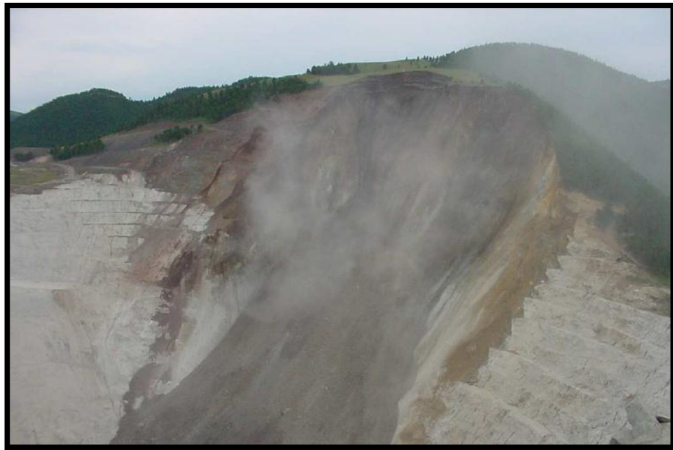
Fotografía 14. Rotura Circular
