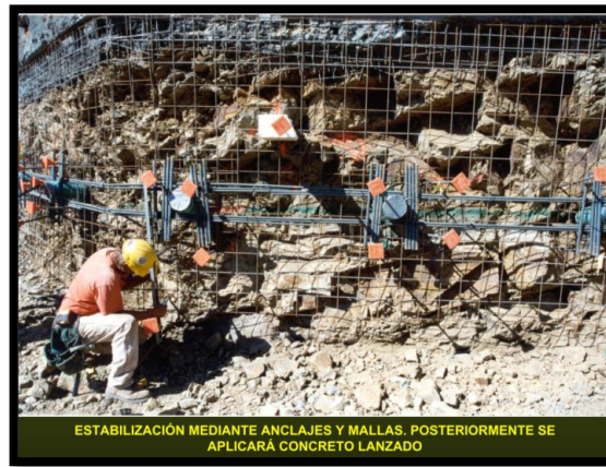
Fotografía 16. Mallas, cables y anclajes para estabilizar talud altamente fracturado
