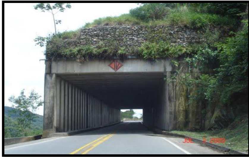
Fotografía 20. Túnel falso vía Bucaramanga-Barrancabermeja.
