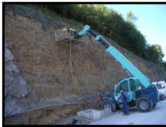
Figura 34. Instalación de Malla de Guiado.
