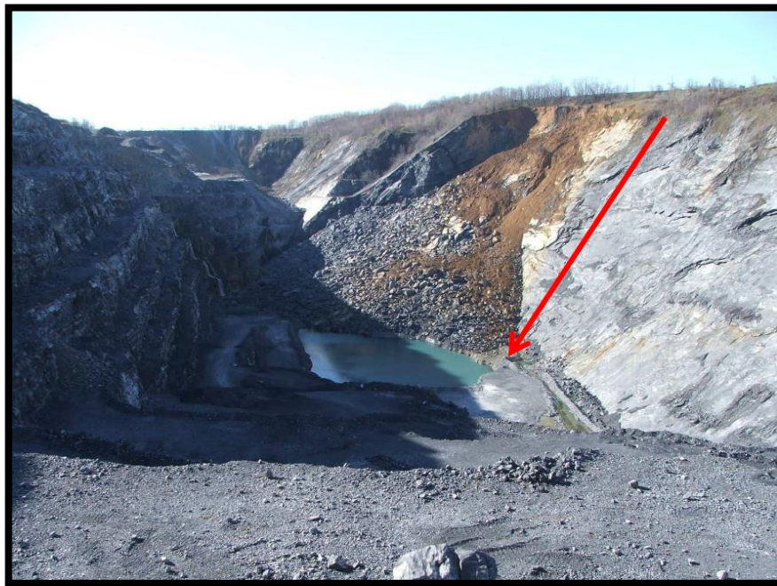
Fotografía 11. Rotura Planar
