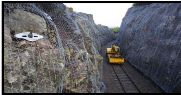
Fotografía 15. Mallas y cables anclados al macizo.
