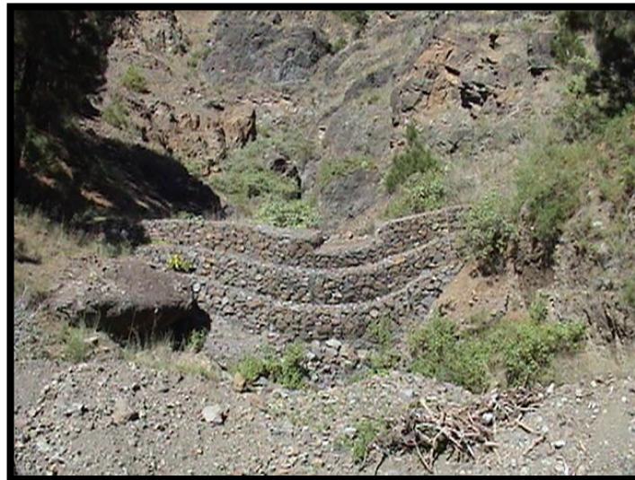
Fotografía 21. Muros en Gaviones
