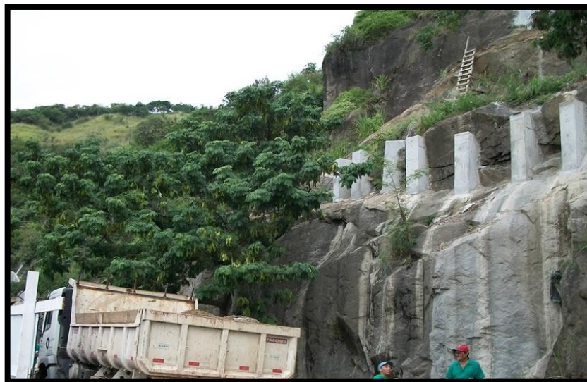
Fotografía 17. Contrafuertes en concreto.
