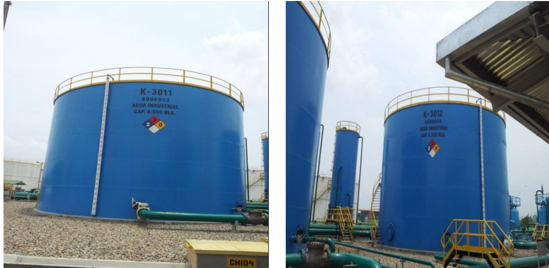
Figura 39. Tanques K-3011 y K-3012, recibo de agua de producción.
