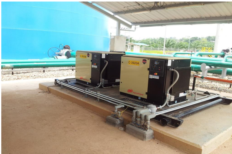
Figura 59. Sistema de compresión de aire para instrumentos.
