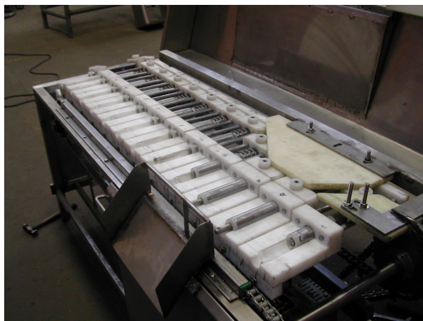
Figura 7.30: Montaje en la estructura
