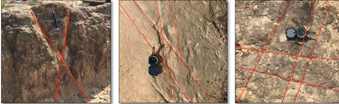
Figura 83. Sistemas de diaclasas conjugadas (ángulo de intersección aproximado de 30^\circ a 60^\circ ) y ortogonales (ángulo de intersección aproximado de 90^\circ ).
