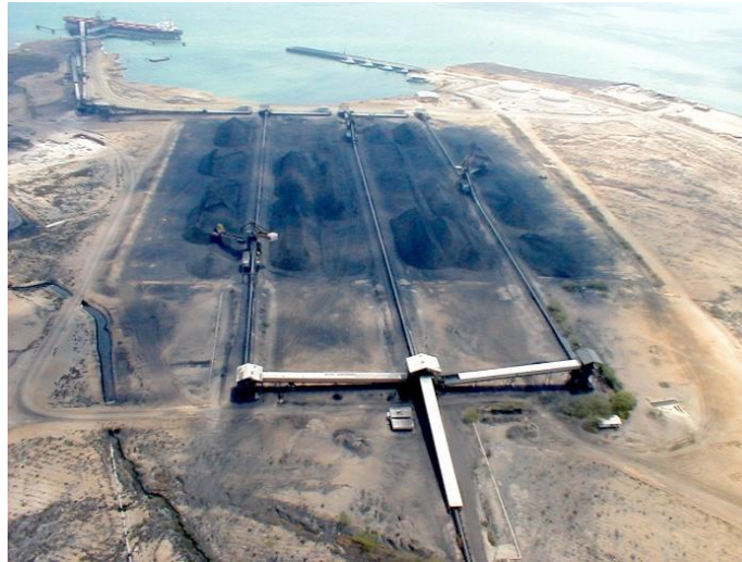
Figura 5. Sistema de Bandas transportadoras
