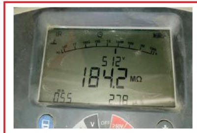
Fig.2 Valor de aislamiento en motor
