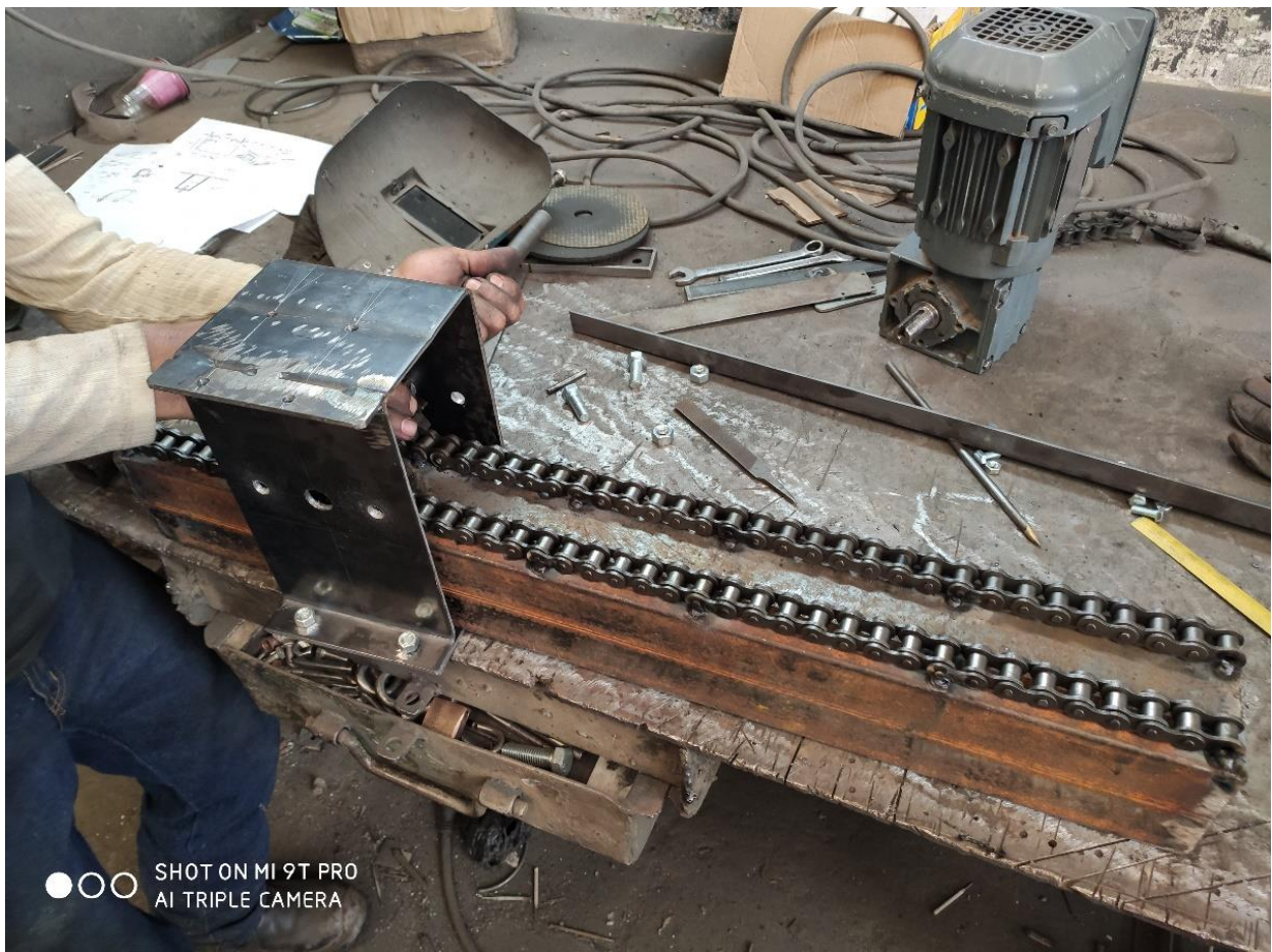
Figura 43. Cadena soldada a vigas
