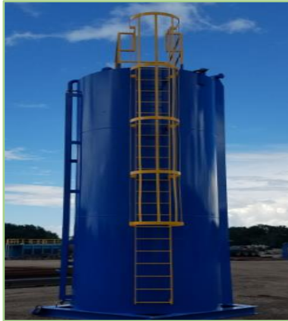
Figura 11. Tanque de almacenamiento.
