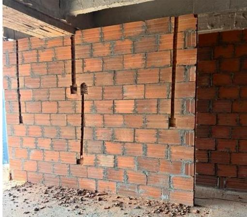
Se verifica que el muro este aplomado y de acuerdo con el plano. Se comprueban que los niveles de alturas de conexiones y salidas cumplan con el reglamento técnico de instalaciones eléctricas (RETIE) según el Ministerio de Minas y Energía (2008), en la figura 17 se aprecia la perforación o regateo realizada por donde se ubican los puntos de conexión.
