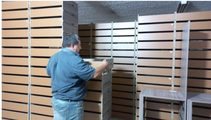
Se instalan las gavetas en los cocos junto con los frentes y se cortan los marcos laterales con un avance acumulado de fabricación del 59%, en la figura 12 se evidencian los marcos laterales cortados.
