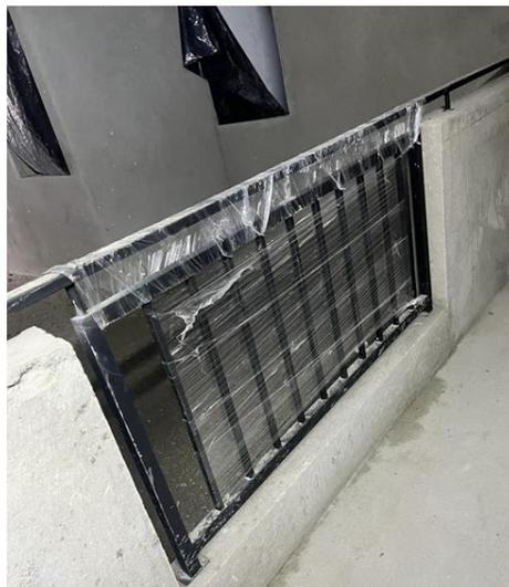
En Bochetti se realiza una perforación de 10 [cm] x 20 [cm] que se rellena con mezcla para poder anclar los pasamanos en los laterales como se observa a continuación en la figura 26.
