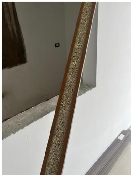
Con el fin de mejorar los acabados por parte de carpintería y así mismo disminuir costos, se requirió de un proceso de mejora en los sobremarcos que se hizo realizando una ranura en estos de 0,6 [cm], esta ranura evita el proceso de relleno de los sobremarcos con sikapintores, disminuyendo así significativamente el costo destinado a acabados, en la figura 28 se aprecia esta mejora.
