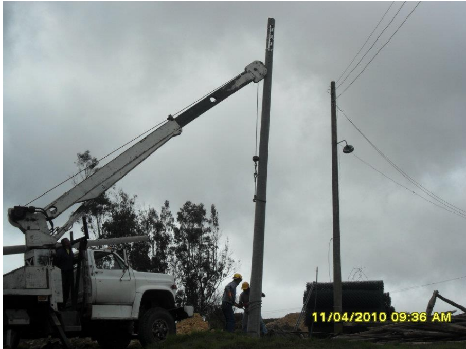
Imagen 5. Grúa – Equipo Pesado
