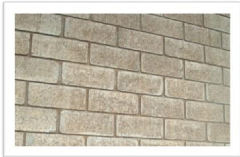
Figura 6 - Pared Exterior Cuartos de Transformador
