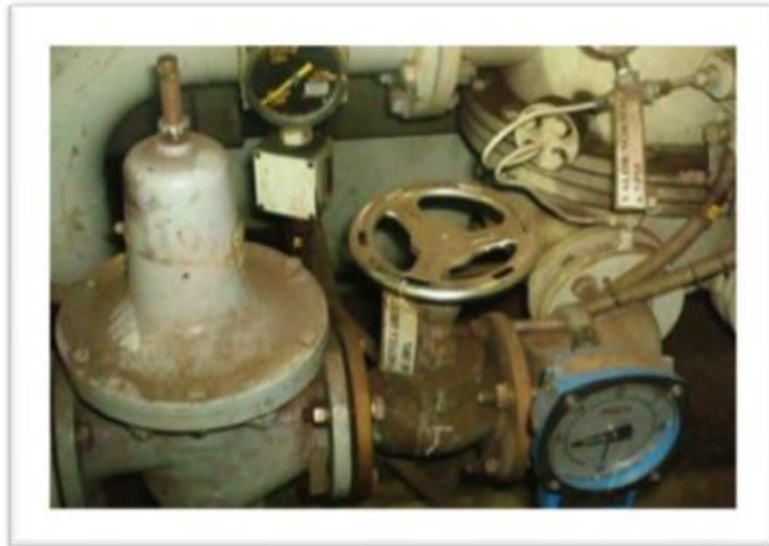
Figura 15 - Etiquetado con rangos y valores nominales
