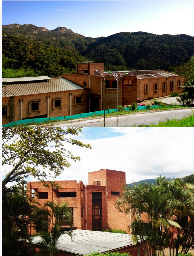
Imagen 1: Instalación Industrias LAVCO.
