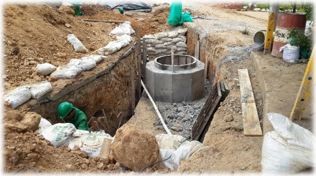
Figura 6. Pozo de inspeccion carrera 6 con calle 42.
