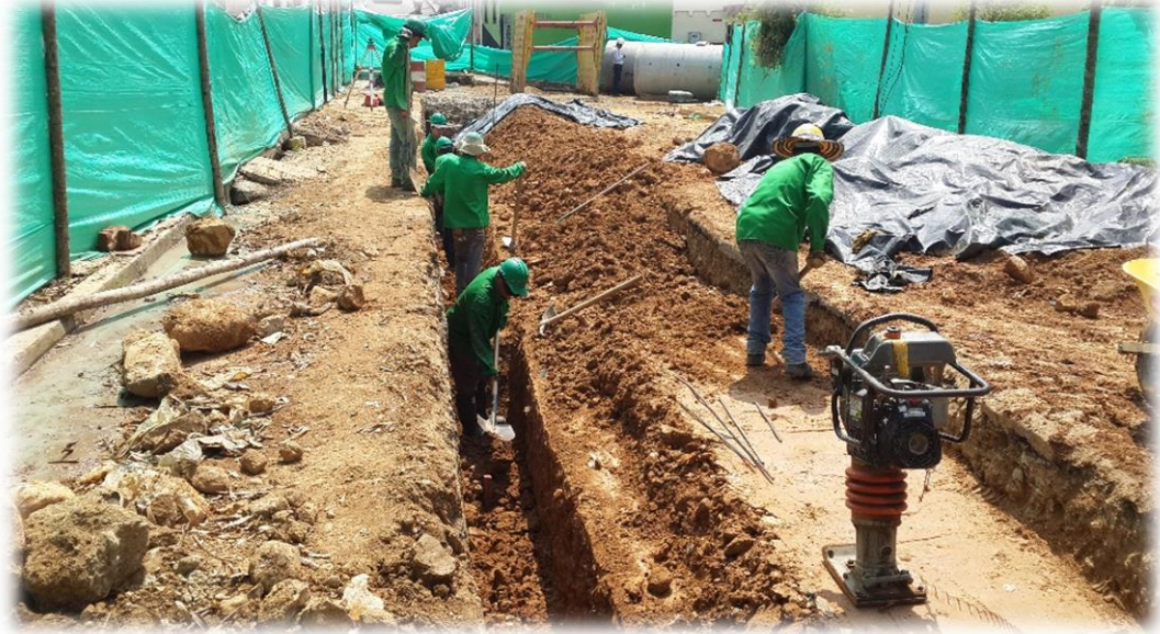
Figura 5. Trabajos carrera 6 con calle 42.
