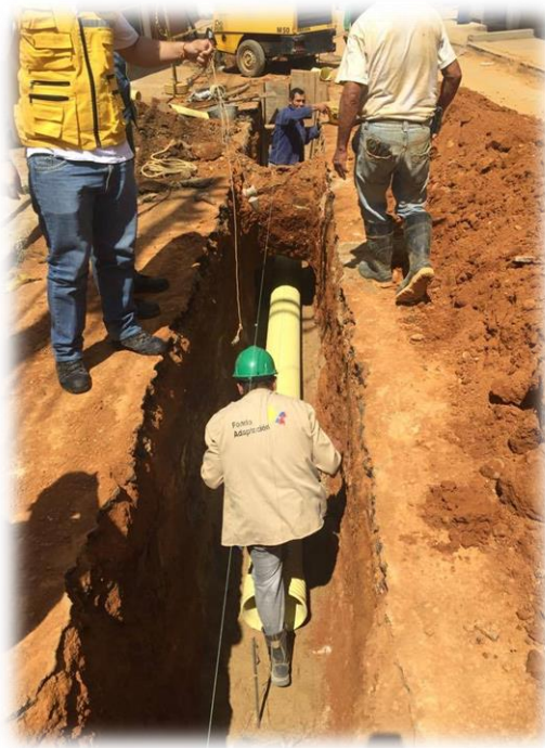
Figura 9. Instalacion tuberia de PVC.
