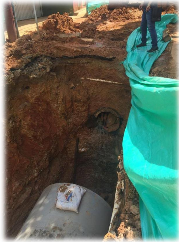
Figura 10. Instalacion tubo de concreto de 1.80 m.
