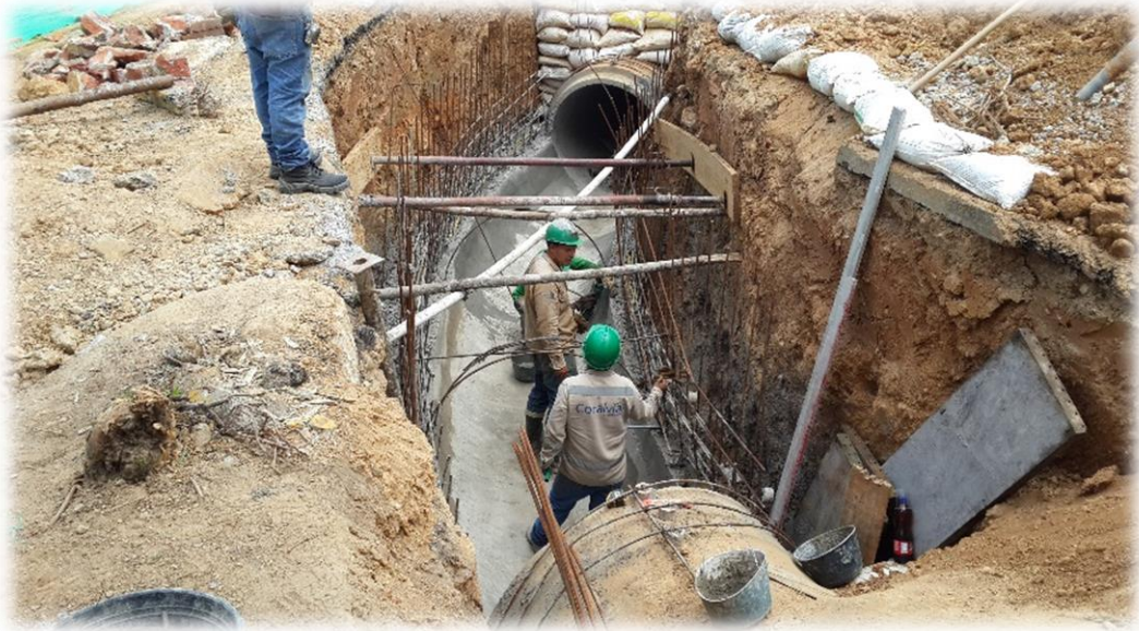
Figura 8. Instalación tubería de concreto 1.30m.
