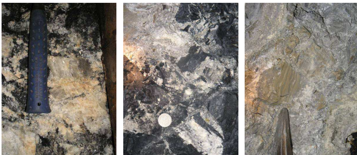
Figura 27. Aspecto de las zonas brechificadas en el interior del túnel “La Mina de Chirripay”. (a) A 136 m de la entrada del túnel se presentan brechas de dolomita romboédrica, con albitización incipiente, y pirita diseminada, acompañados de fragmentos líticos de limolita encajante (Dominio 1, zona 2); (b) a 134 m de la bocamina se aprecian brechas de albita (por reemplazamiento) junto a clastos de limolita muy angulares (Dominio 1, zona 2); (c) a 79 m de la entrada principal del túnel se observan clastos subredondeados asociados a limolita hidrotermalizada y cementados con albita-dolomita (Dominio 2, zona 2).
