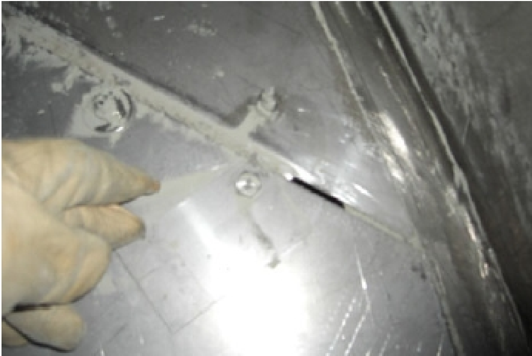
Figura 25. Polvo en bandeja de los distribuidores de la torre Deetanizadora
