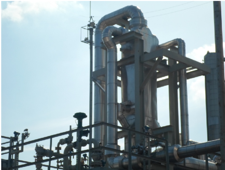
Figura 30. Intercambiador de calor de aluminio soldado de la planta en estudio E-4045/50.
