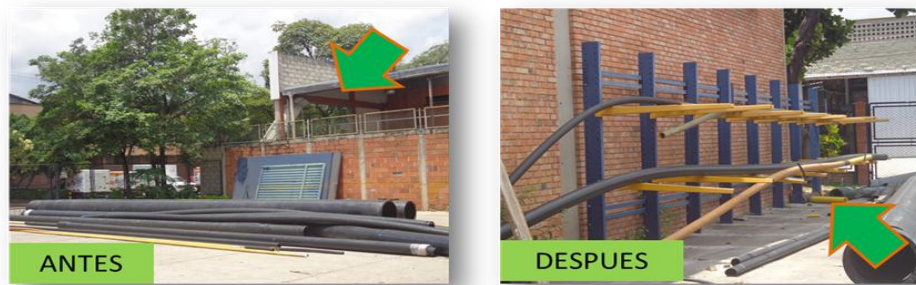
Imagen 33. Zona para almacenamiento de tramos para el tiraje de línea
