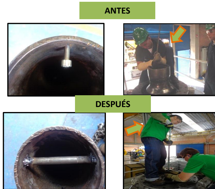
Imagen 35. Adecuación del tubo de succión
