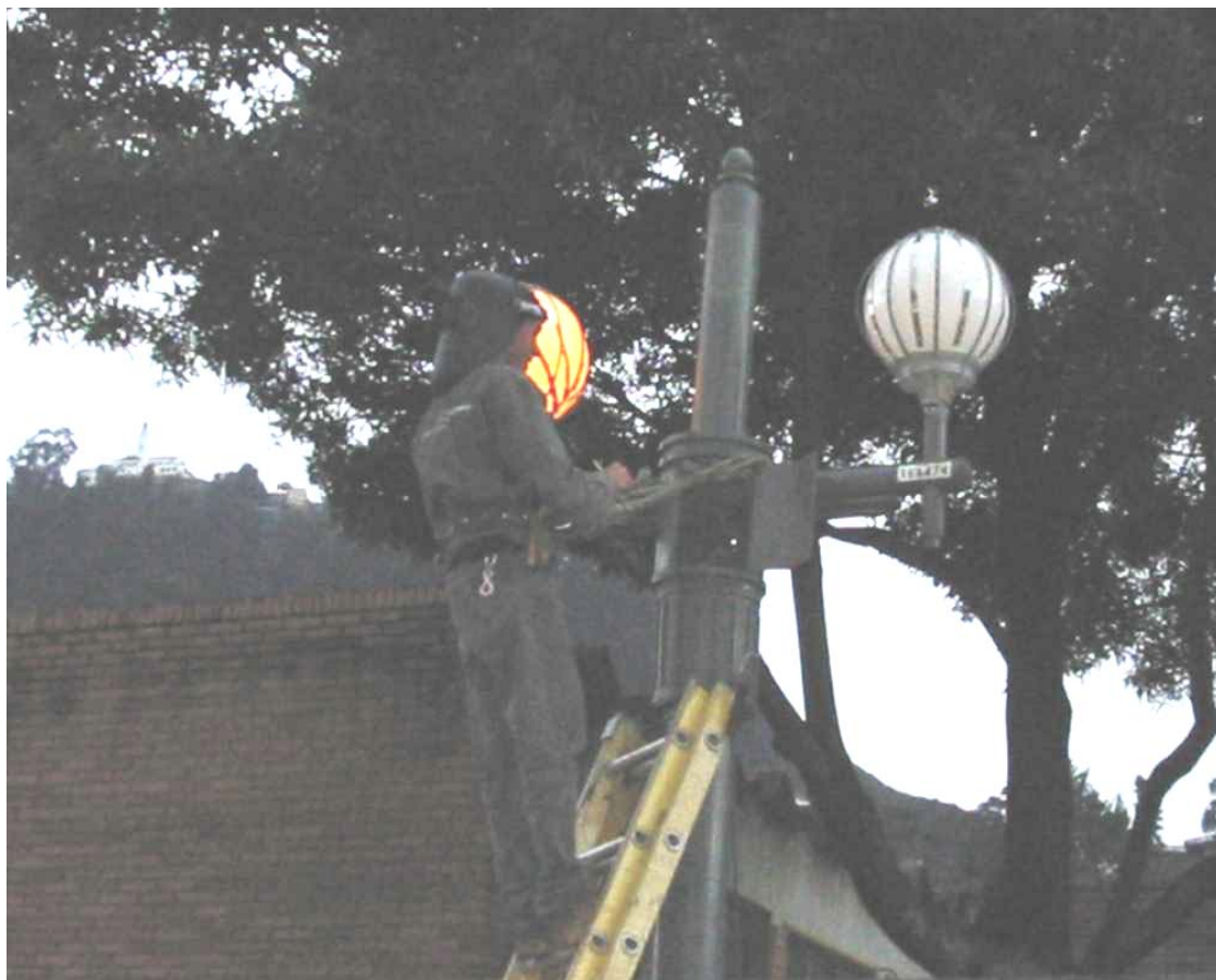
Foto 9. Aplicación de las Normas de Seguridad en la revisión de las bombonas en un poste histórico con doble brazo.
