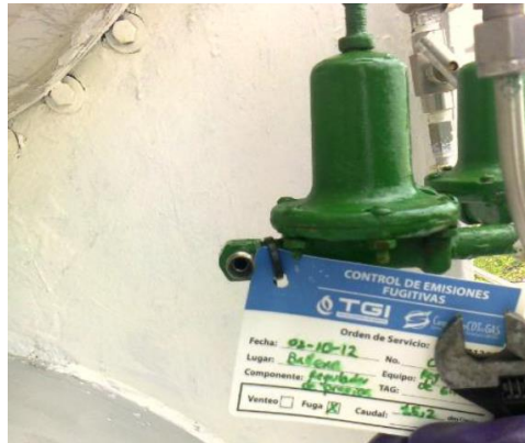
Imagen 12. Cambio de la válvula reguladora de presión del rehervidor
