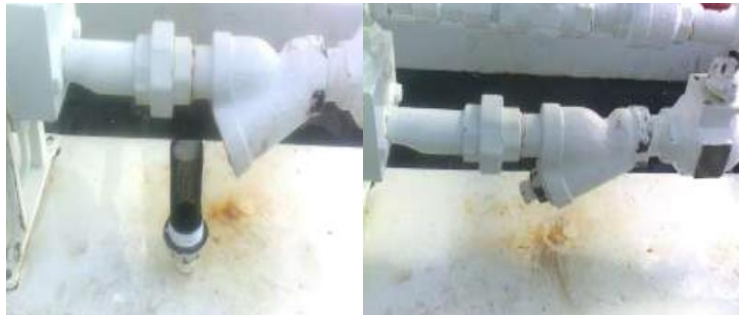
Imagen 8. Corrección emisiones en conexión roscada
