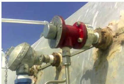
Imagen 9. Corrección fugas en conexiones roscadas/ tubing de regenerador
