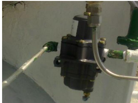
Imagen 13. Cambio de la válvula reguladora de presión del rehervidor
