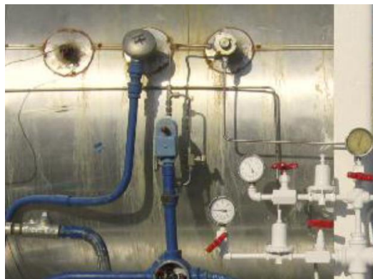
Imagen 6. Corrección conexiones roscadas/tubing en regenerador
