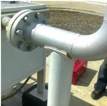
Imagen 7. Cambio empaques condensador
