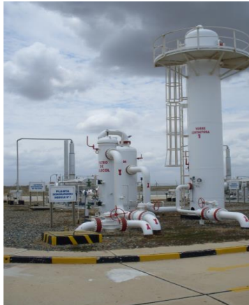
Imagen 3. Torre contactora del tren de deshidratación No. 1
