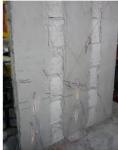
Figura 14. Muro reforzado con textil (TRC).
