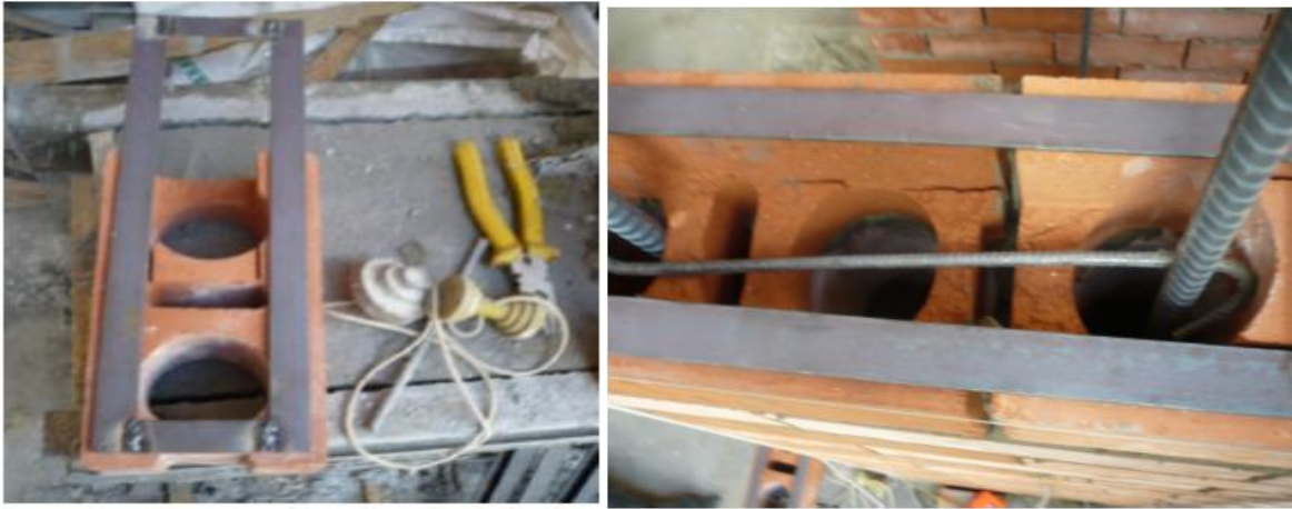
Figura 12. Platina De Refuerzo Y Elemento De Borde.
