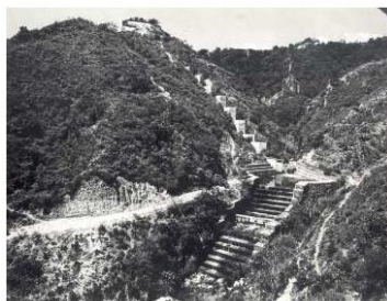
Figura 33 Estructura de entrega de aguas residuales
