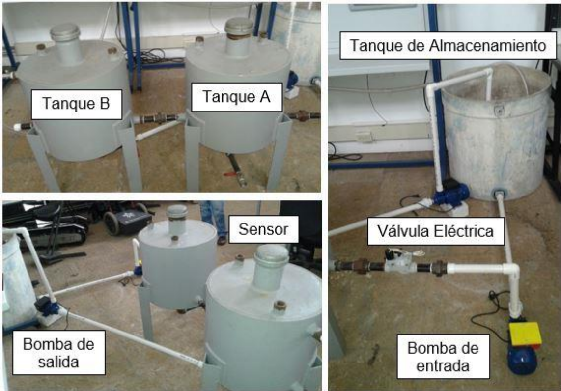
Figura 9. Sistema construido para control de nivel de líquido.
