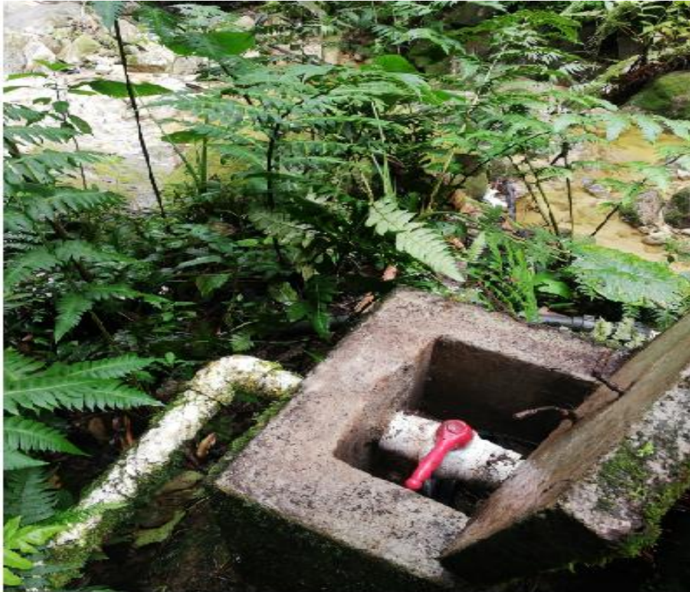
Figura 8. Detalle de la zona de salida del desarenador del acueducto veredal CORPOAGUAS.
