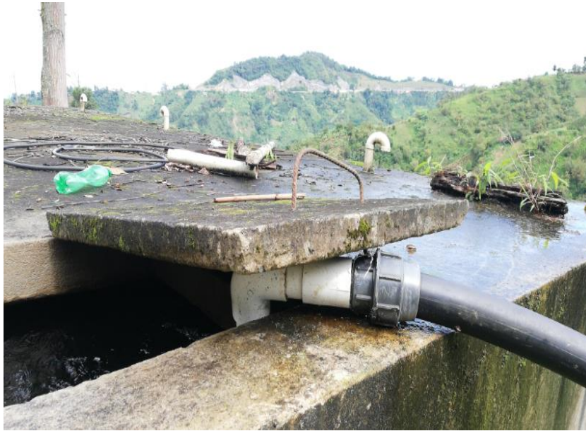
Figura 10. Detalle de la tubería de entrada al tanque de almacenamiento del acueducto veredal CORPOAGUAS. Adaptada de IMMA S.A.S, 2019.
