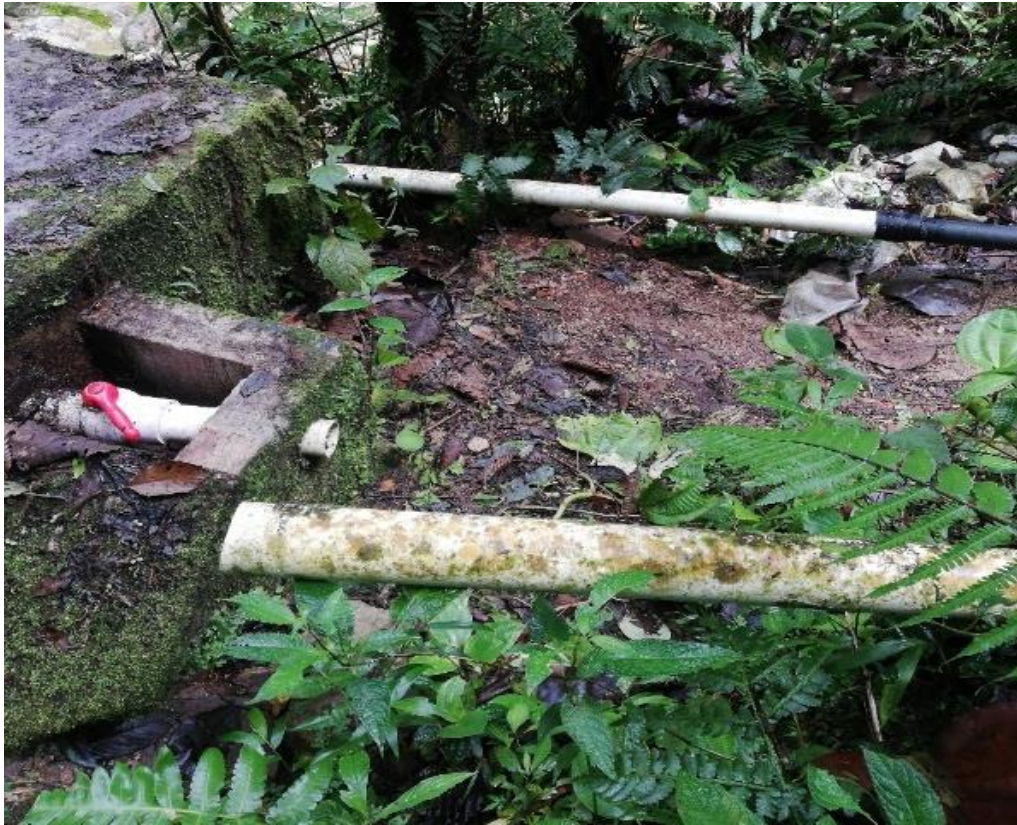
Figura 7. Detalle de la zona de entrada al desarenador del acueducto veredal CORPOAGUAS.
