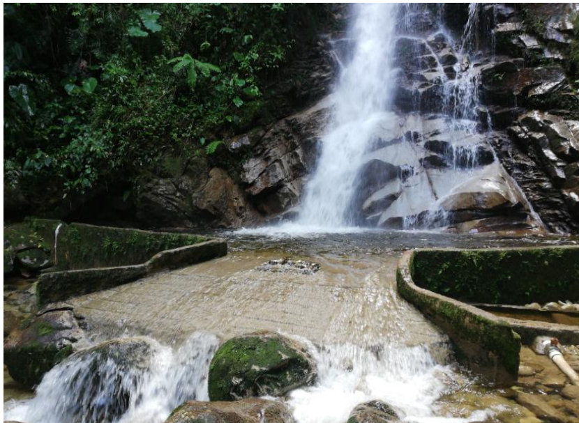
Figura 4. Obra de captación del acueducto veredal CORPOAGUAS. Adaptada de IMMA S.A.S, 2019.
