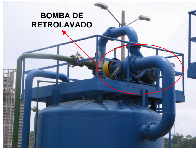
Figura 29. Ubicación de una bomba de retrolavado en unidad de filtración
