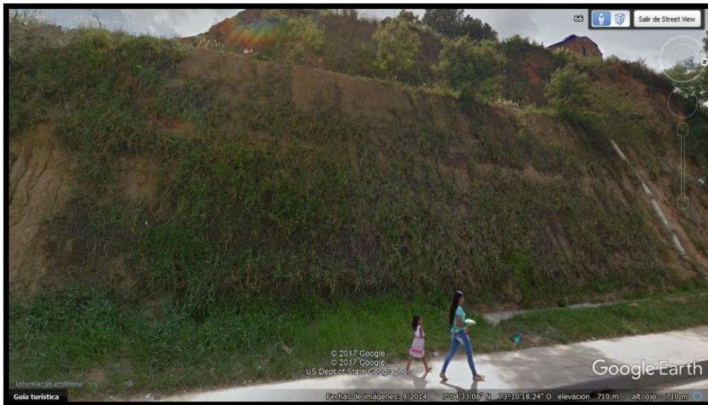
Figura 9. Obras para la mitigación implementadas en Bellavista. Adaptada de Google Earth, año 2014.
