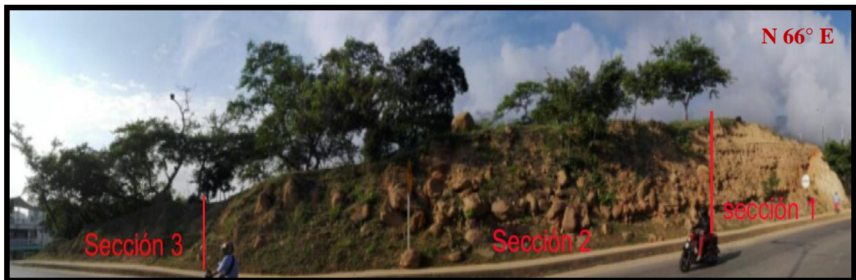
Figura 19. Fotografía panorámica del talud en la cual se ubican las tres diferentes secciones encontradas.
