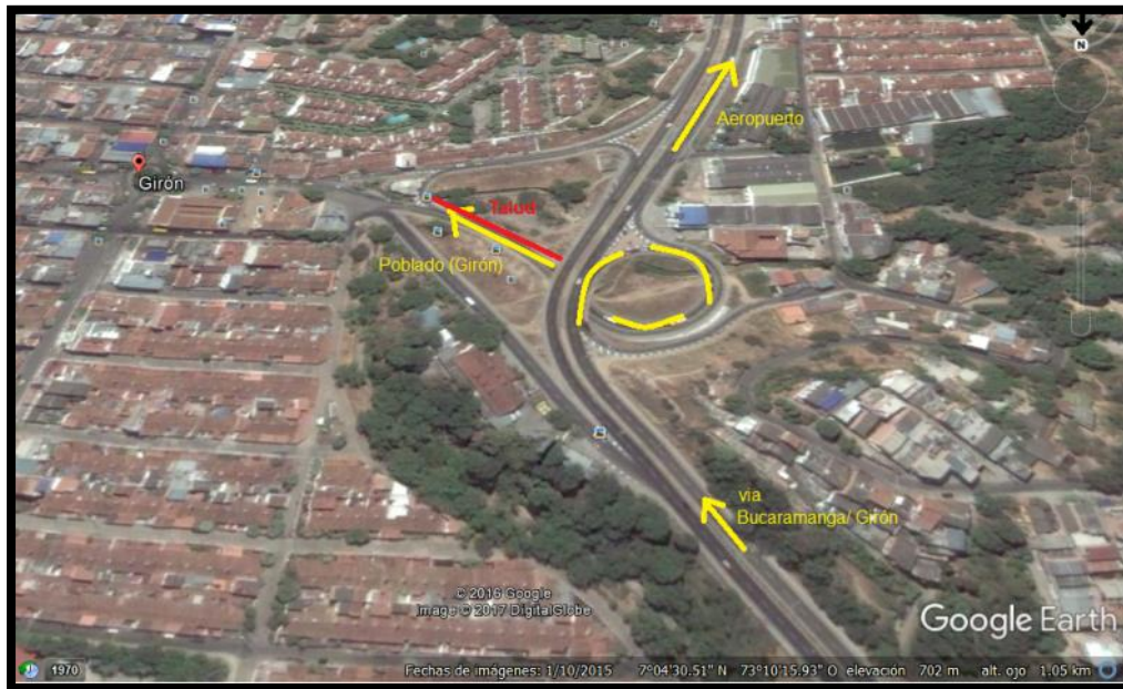
Figura 2. Ubicación satelital del talud. Adaptada de Google Earth (2017).
