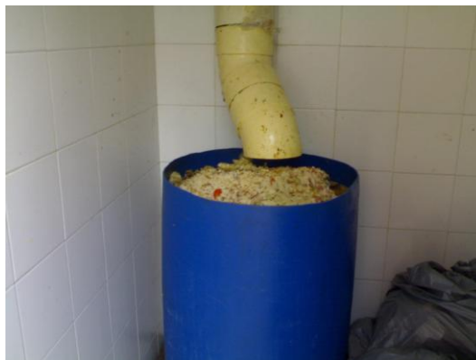
Figura 17. Interior de la caseta de alimentación.
