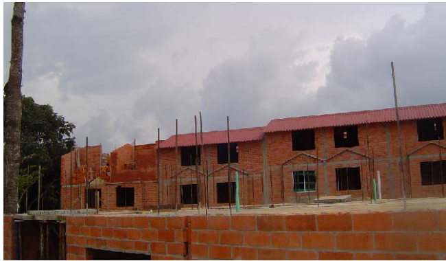
Fotografía 4: Prolongación del refuerzo vertical a través de la placa
