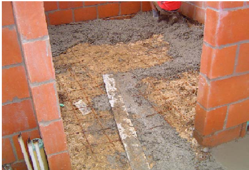
Fotografía 7: Camisa que recubre la tubería del gas
