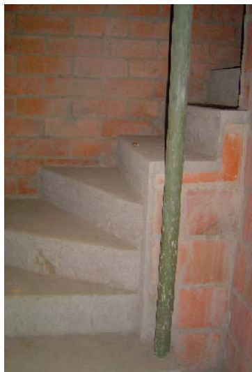
Fotografía 11: Escalera morteriada
