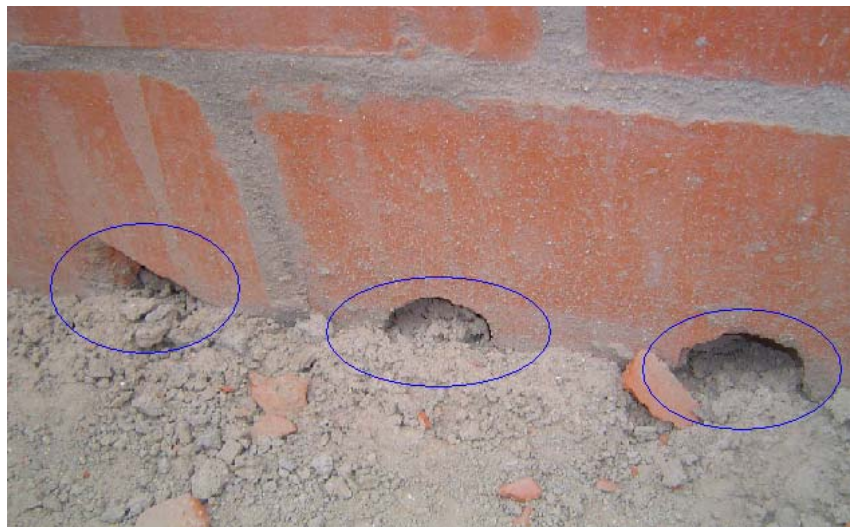
Fotografía 5: Celdas de inspección
