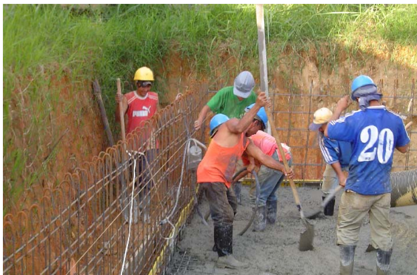
Fuente: Obra Villas de San Patricio
