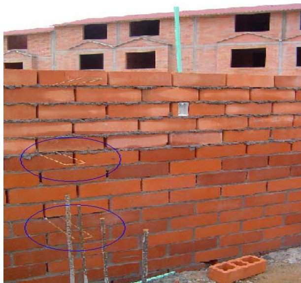
Fotografía 3: Conectores utilizados como refuerzo
