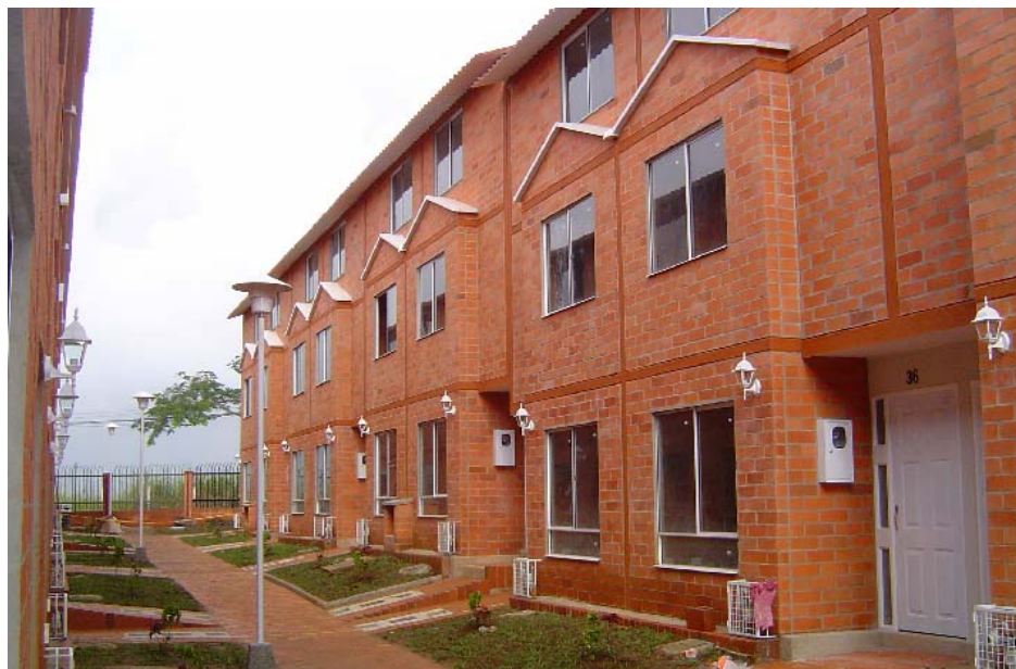
Fuente: Obra Villas de San Patricio
