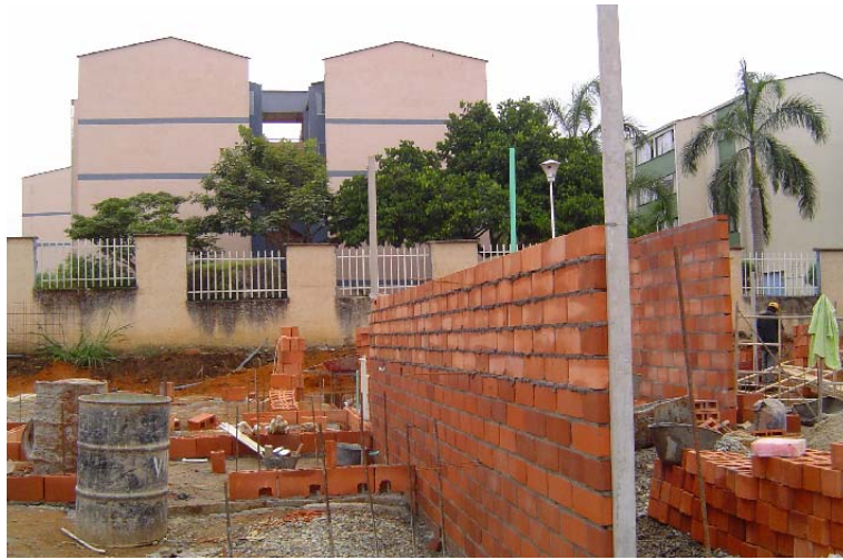
Fuente: Obra Villas de San Patricio
