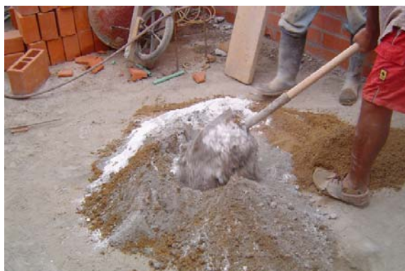
Fuente: Obra Villas de San Patricio
