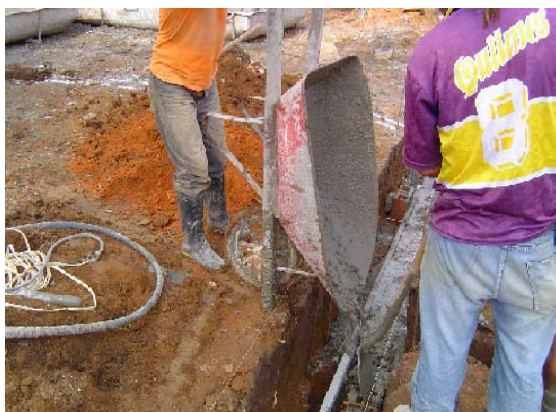
Fotografía 20: Vaciado del concreto en la zanja
