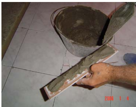
Fotografía 13: Aplicación de la mezcla a la losa
