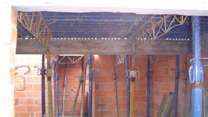
Fuente: Obra Villas de San Patricio
