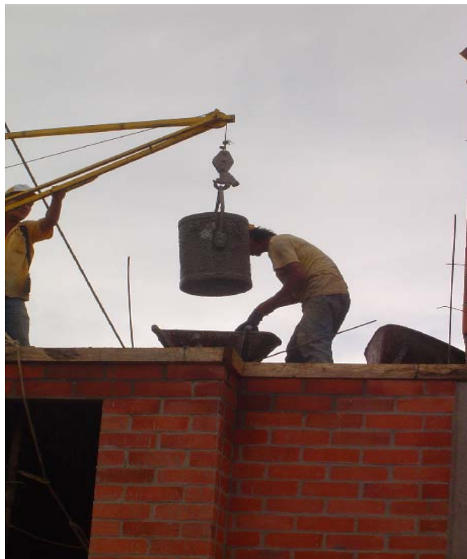
Fuente: Obra Villas de San Patricio
