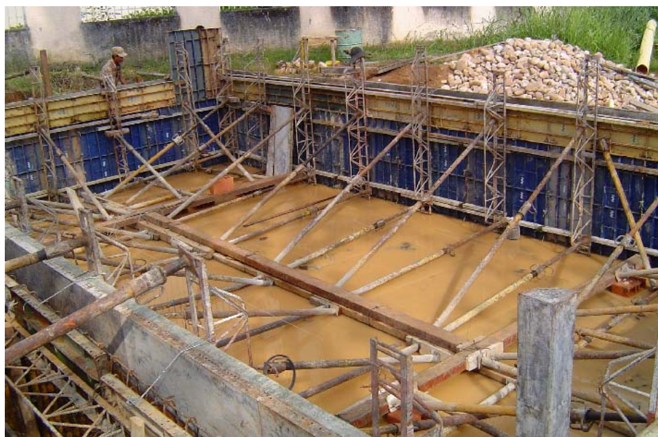
Fuente: Obra Villas de San Patricio
