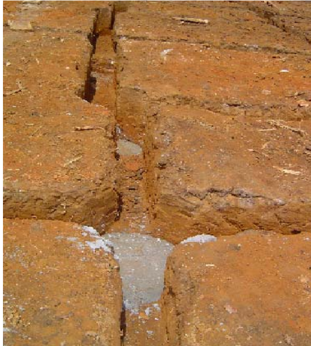
Fotografía 16: Excavación de las vigas de cimentación
