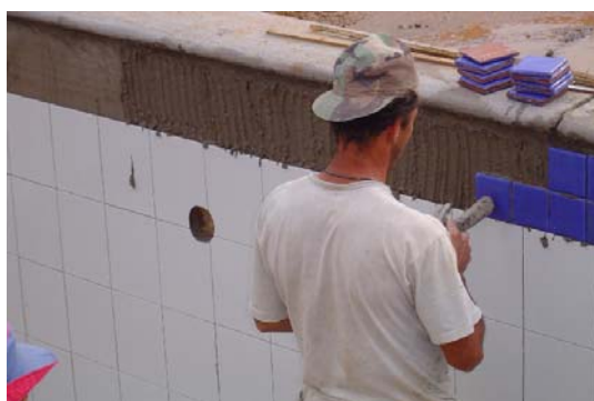
Fuente: Obra Villas de San Patricio
