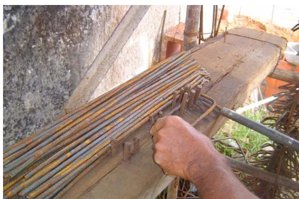
Fuente: Obra Villas de San Patricio
