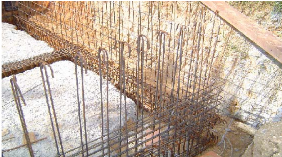
Fuente: Obra Villas de San Patricio
