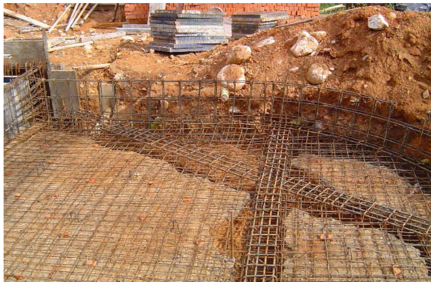
Fuente: Obra Villas de San Patricio
