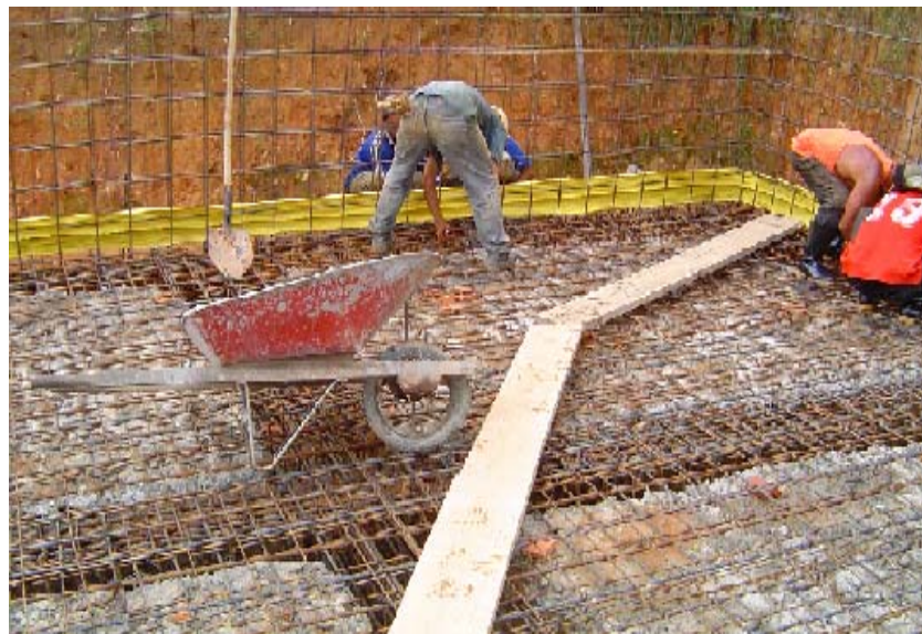
Fuente: Obra Villas de San Patricio
