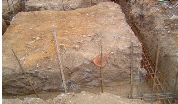
Fuente: Obra Villas de San Patricio
