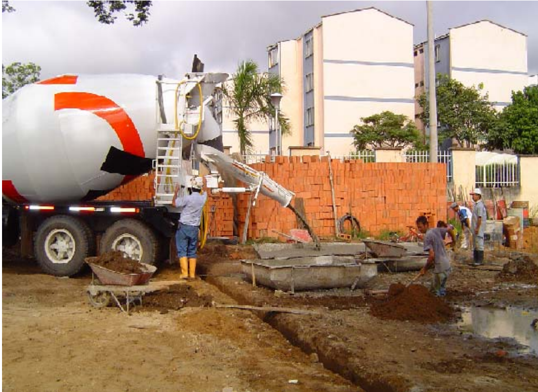
Fuente: Obra Villas de San Patricio
