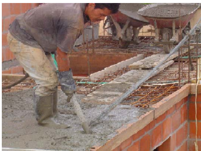
Fuente: Obra Villas de San Patricio
