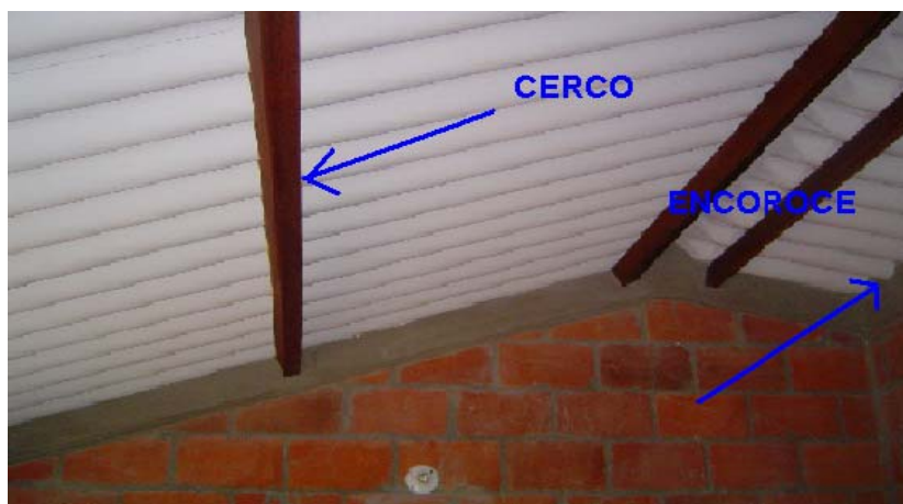
Fotografía 10: Detalle de la cubierta en asbesto cemento
