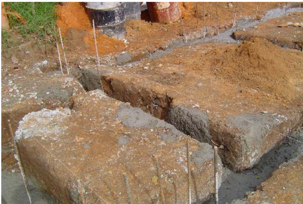
Fotografía 18: Cimentación una vez se ha terminado la fundida
