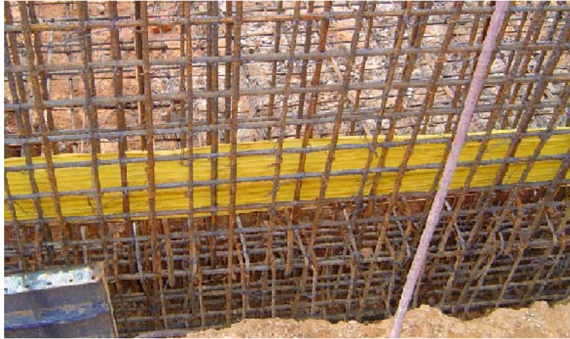
Fuente: Obra Villas de San Patricio
