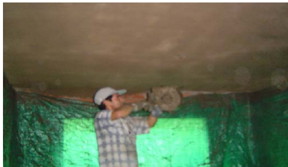
Fotografía 14: Aplicación del rústico en la placa
