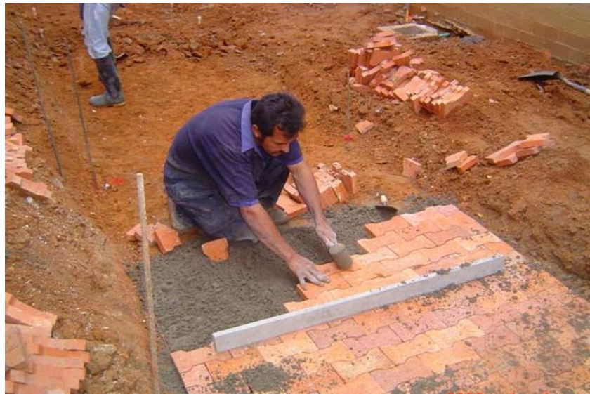
Fuente: Obra Villas de San Patricio
