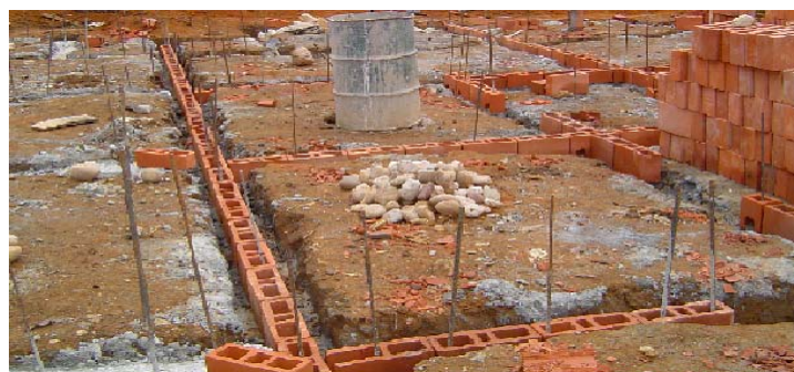
Fuente: Obra Villas de San Patricio
