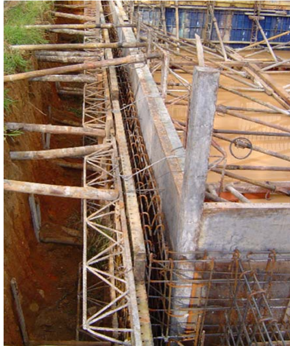
Fuente: Obra Villas de San Patricio
