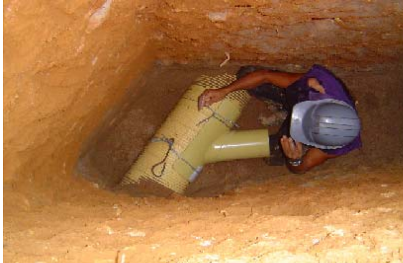
Fuente: Obra Villas de San Patricio
