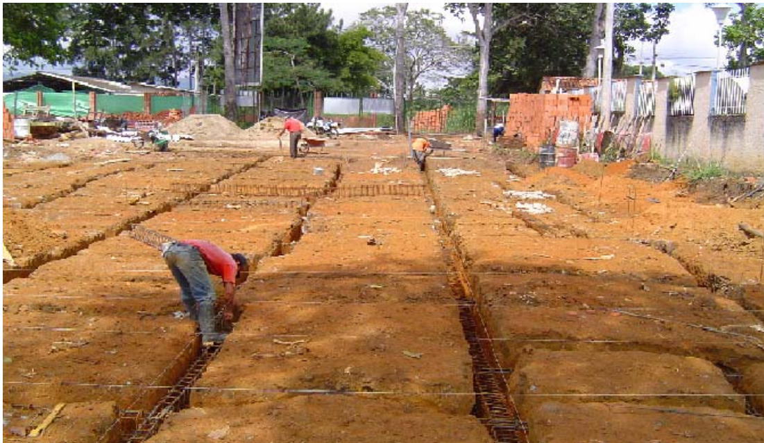
Fotografía 16: Panorámica de la armada de la cimentación
