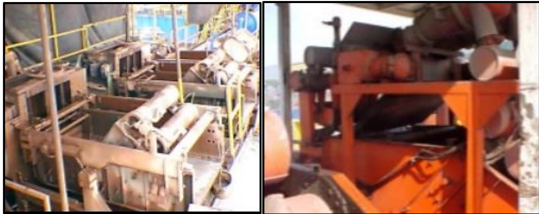
Figura 73. Izquierda. Zaranda vibratoria. Derecha. Hidrociclones
