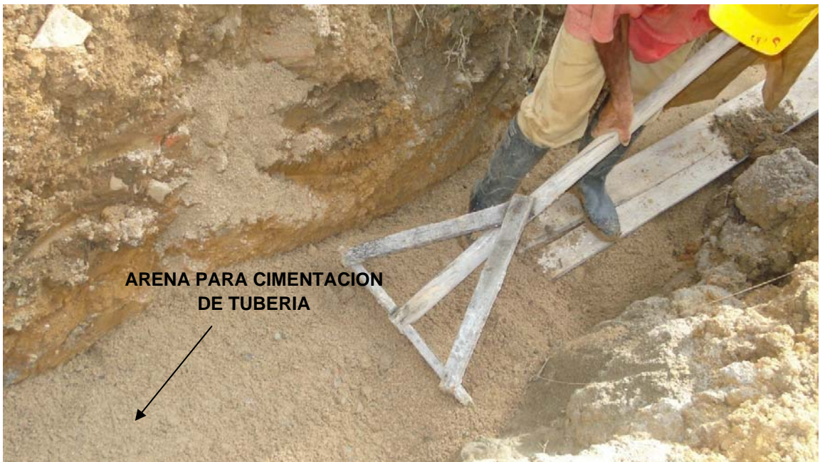
Figura 43 Replante para cimentación
