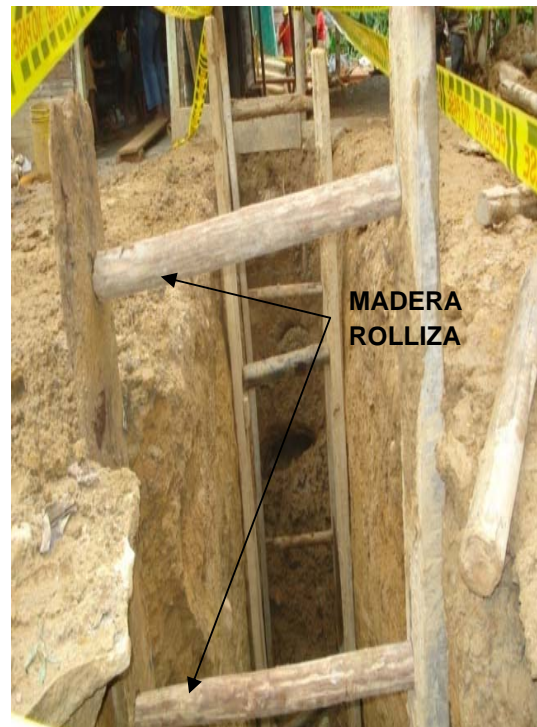
Figura 31 Entibados de zanjas
