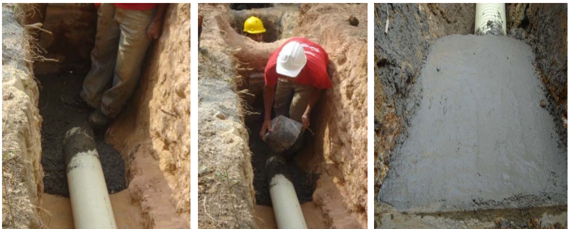
Figura 48 Atraque de Tubería
