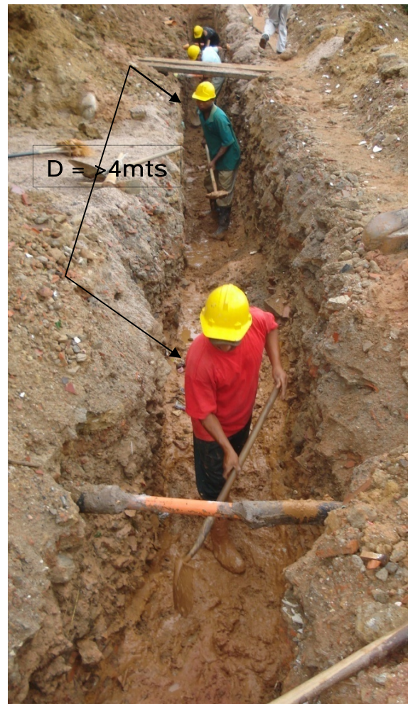
Figura 28 Excavación en zanjas
