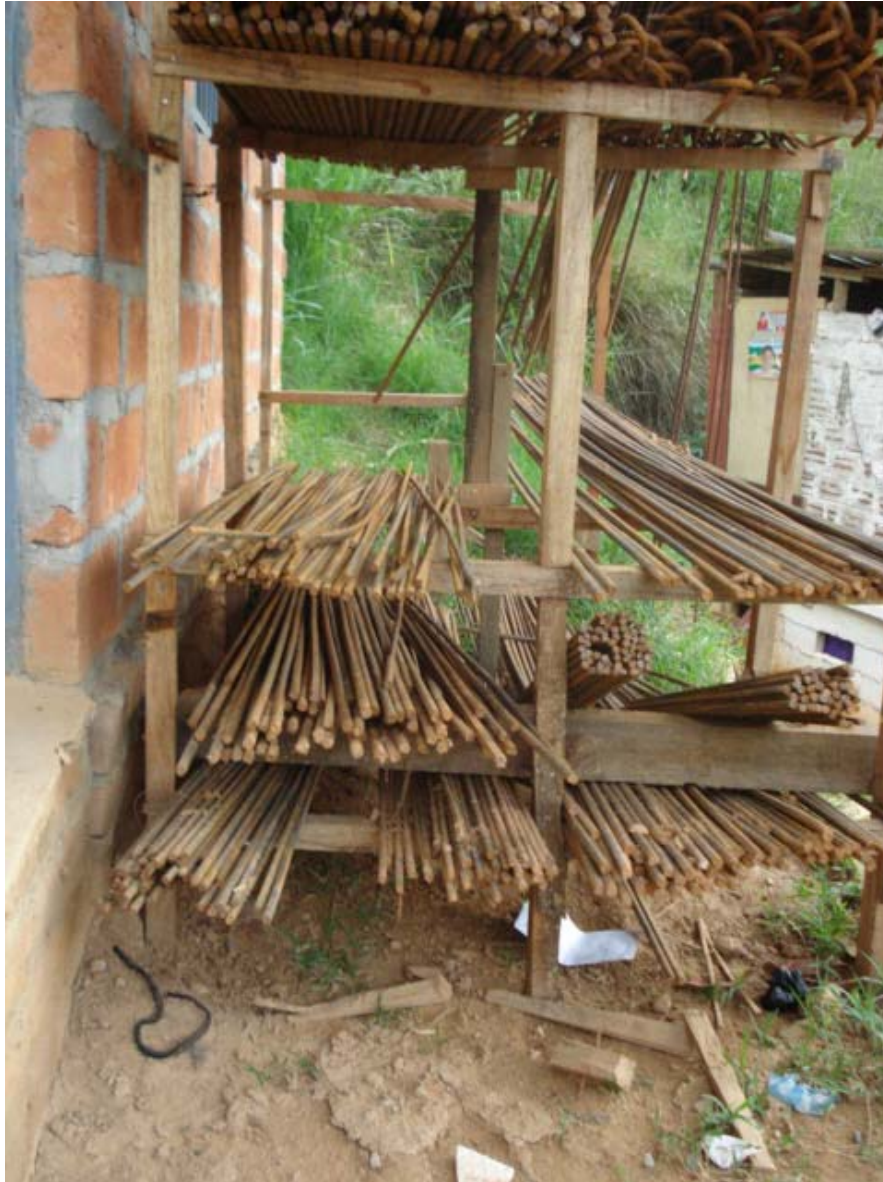
Figura 21 Almacenamiento de Acero en obra
