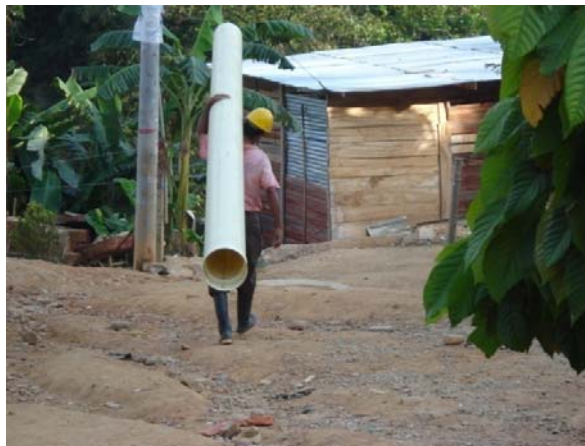
Figura 25 Cargue de la tubería
