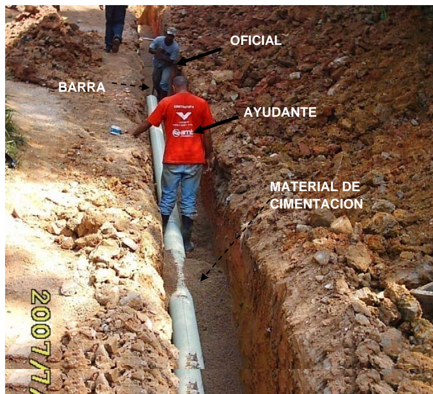
Figura 46 Instalación de tubería
