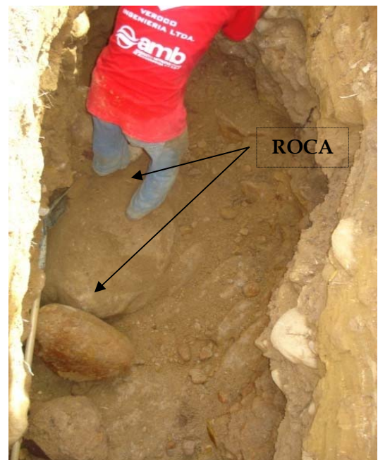
Figura 29 Excavación en roca
