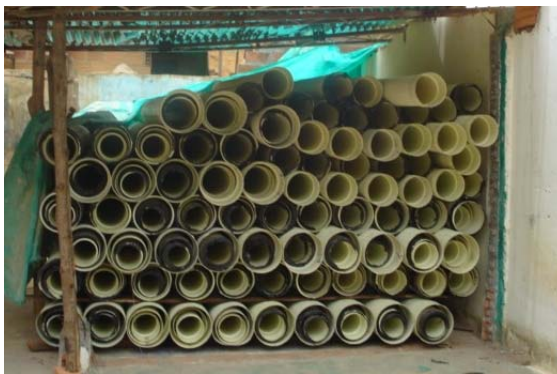
Figura 27 Almacenamiento de Tubería en obra
