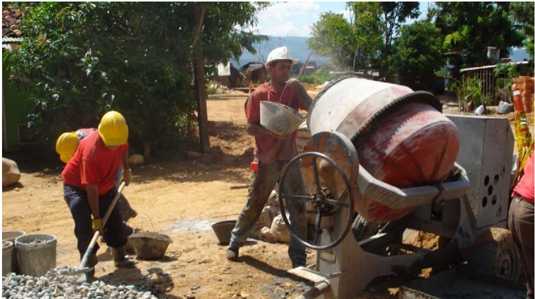
Figura 18 Elaboración de concreto en obra
