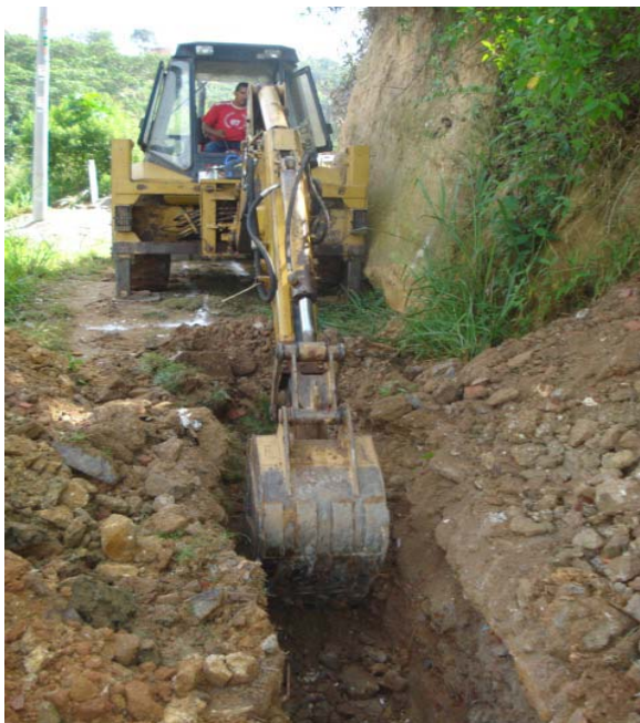
Figura 30 Excavación con maquina
