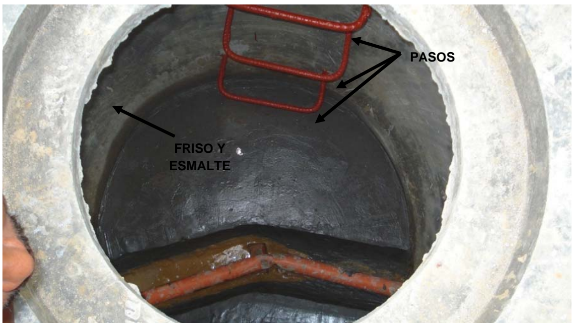
Figura 67 Pasos de pozos de inspección
