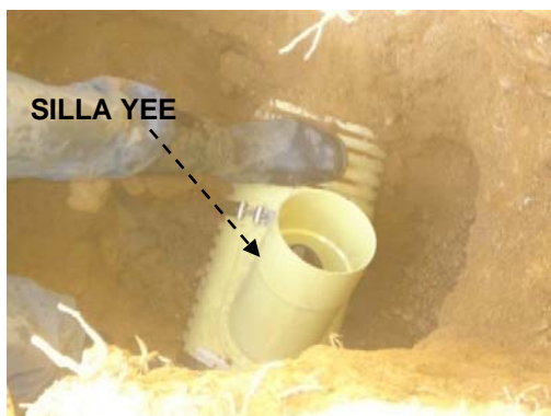
Figura 55 Instalación de domiciliaria
