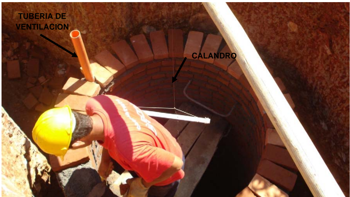
Figura 66 Levante de pozo de inspección
