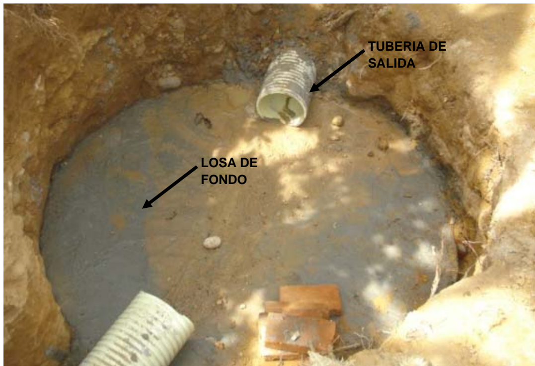
Figura 60 Losa de Fondo
