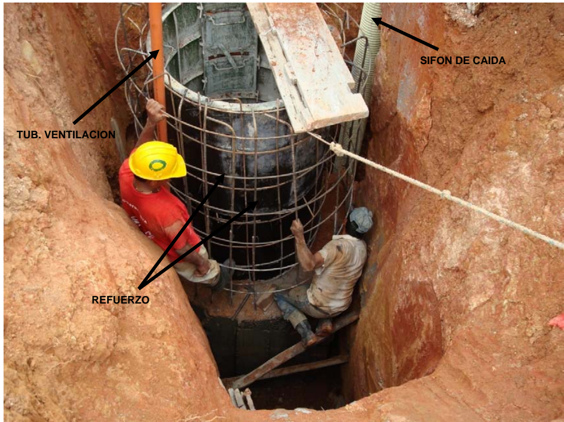
Figura 62 Cilindro en concreto reforzado
