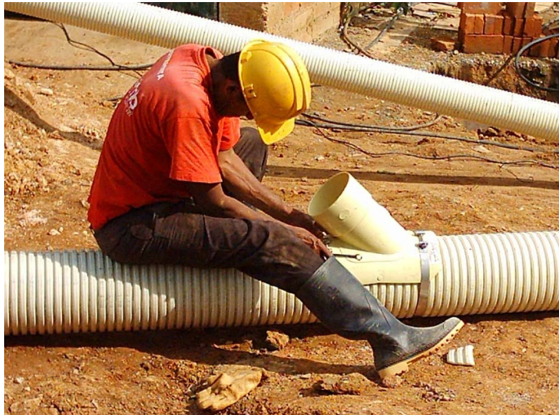
Figura 54 Colocación de Silla Yee
