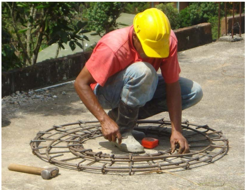
Figura 72 Armaje del refuerzo para corona
