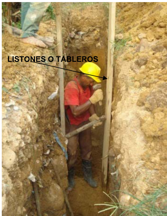
Figura 32 Construcción de Entibados
