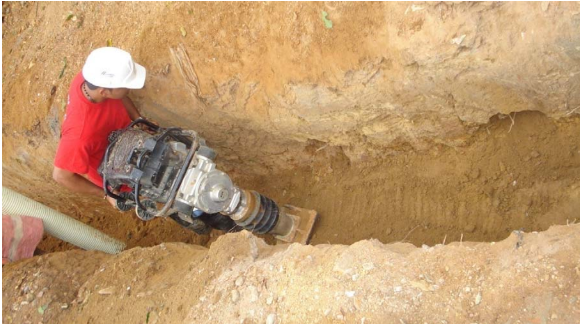
Figura 58 Rellenos de zanjas
