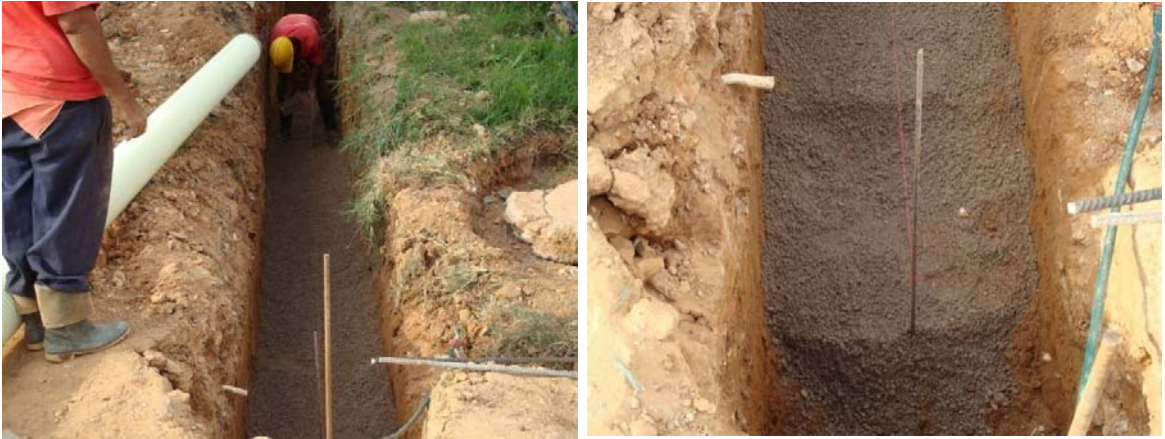
Figura 42 Cimentación de tubería
