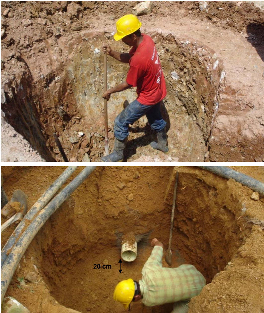
Figura 33 Excavación para pozos
