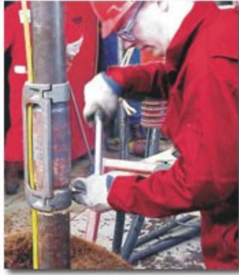
Figura 4-1: Adecuación de cable de fibra óptica en tubing para fondo de pozo.
