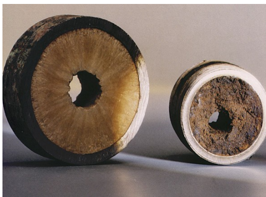
Figura 2-4: Disminución de diámetro en tubing por precipitación de parafinas y asfáltenos.
