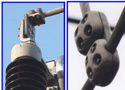
Figura 8. Conector entre cable y equipo, y entre cables de alta tensión
