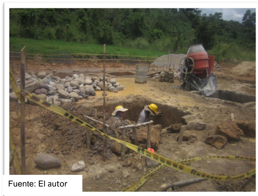
Figura 15. Concreto Ciclópeo
