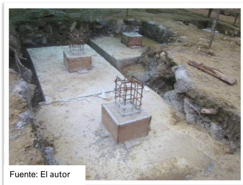
Figura 16. Cimentación fundida
