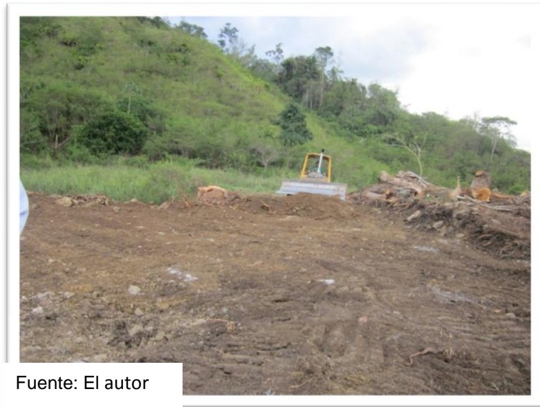
Figura 12. Proceso de Descapote
