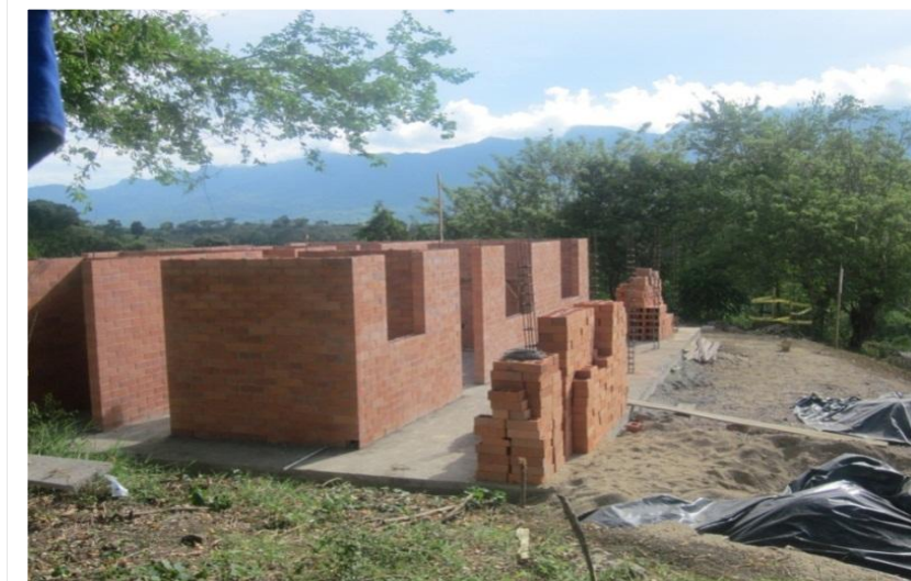
Figura 22. Mampostería hasta 2,2 m
