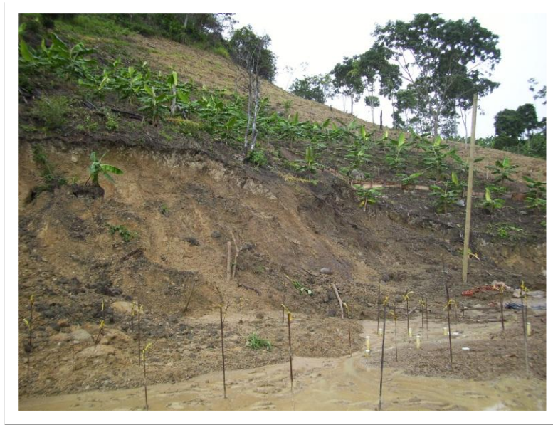
Figura 36. Talud Posterior Vivienda
