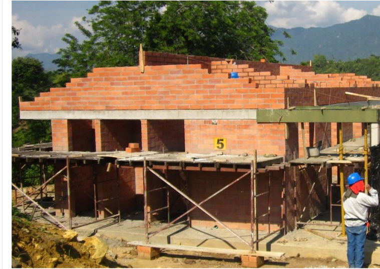
Figura 24. Instalación Mampostería Cuchillas
