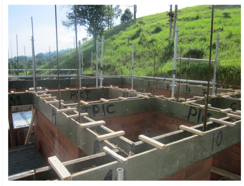
Figura 23. Formaleta Instalada Viga Corona
