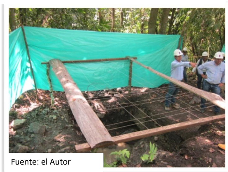
Figura 10. Panorámica acueducto desarenador
