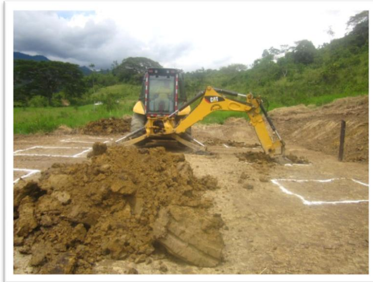
Figura 13. Proceso de Excavación Cimentación
