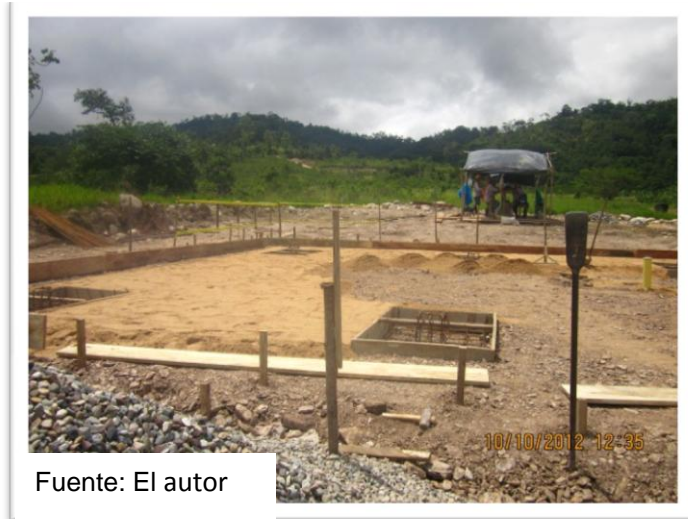
Figura 19. Colchón de Arena en Proceso
