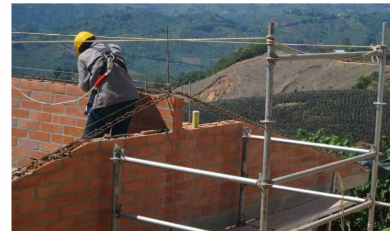
Figura 25. Instalación Mampostería Cuchillas
