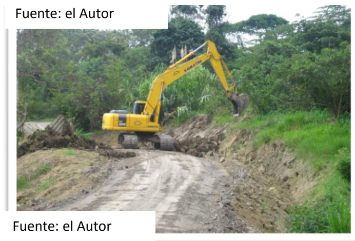
Figura 9. Retroexcavadora trabajando en vías de acceso
