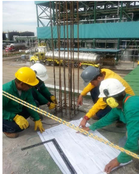
Figura 12. Verificando despieces de columnas.
