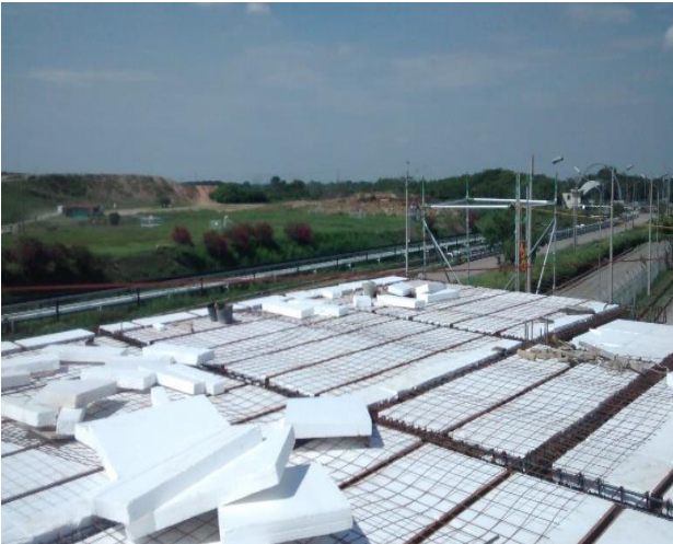
Figura 6. Duralosa durapanel tomada en obra.
