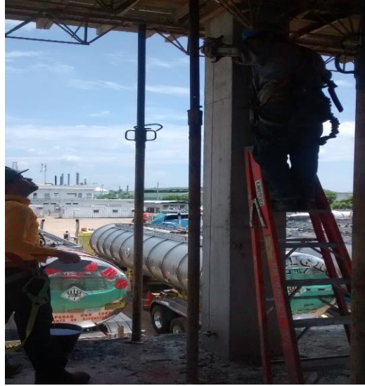
Figura 13. Verificando el plomo de las columnas.
