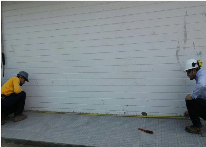
Figura 18. Verificación de cantidades de obra en sitio para corte de avance parcial.
