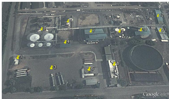
Figura 1. Vista aérea de la planta productora de biodiesel.
