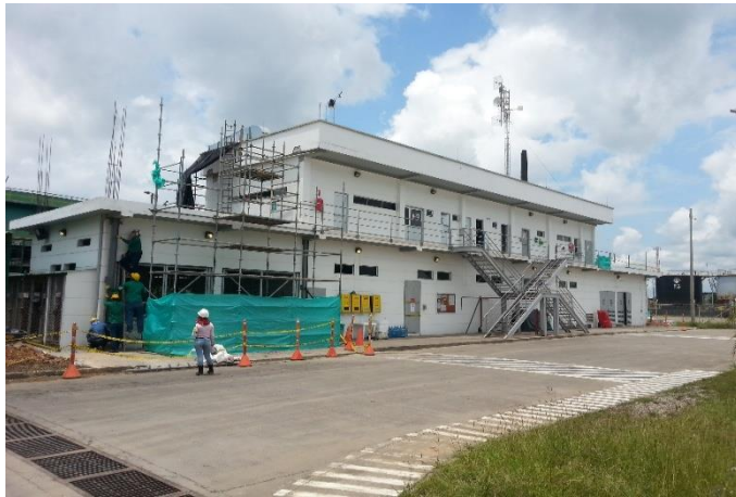
Figura 7. Inicio construcción ampliación edificio administrativo.
