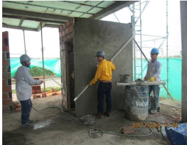
Figura 14. Inspección de plomo, nivel y alineamiento a muro en mampostería
