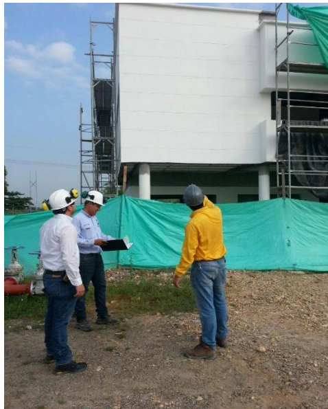
Figura 16. Inspección de obra (fachada).
