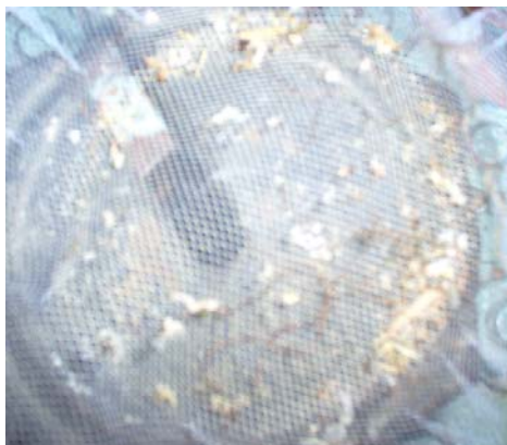
Figura 76. Filtro obstruido parcialmente.
