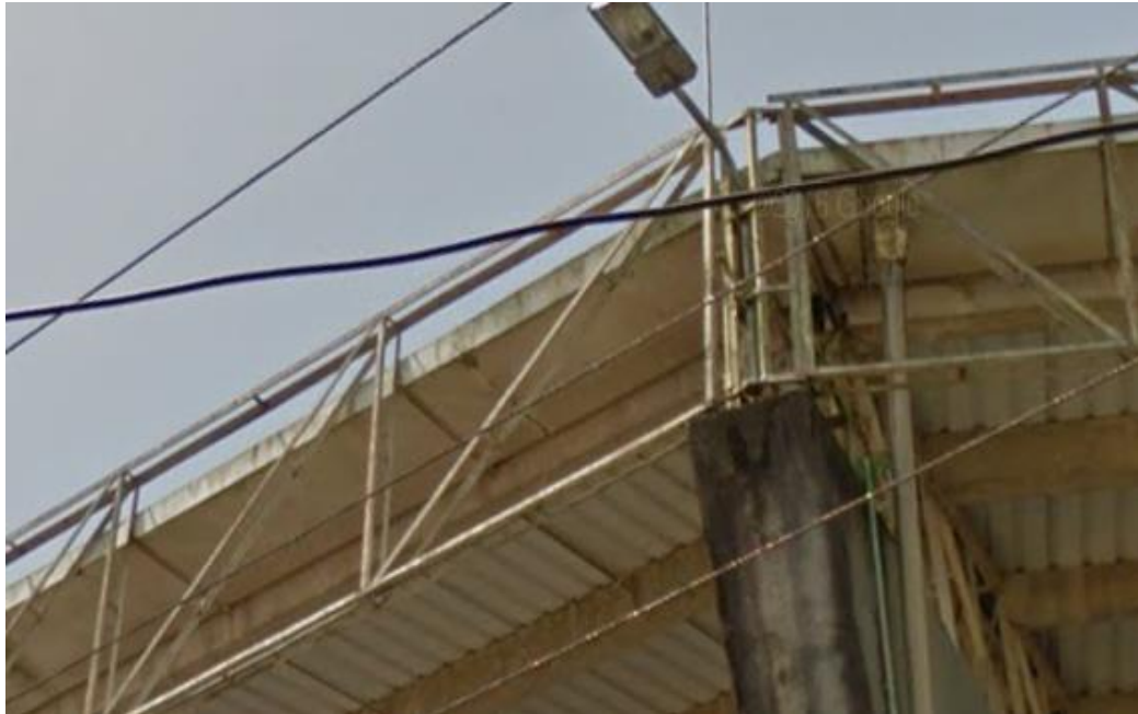
Figura 47. Estructura del coliseo.
